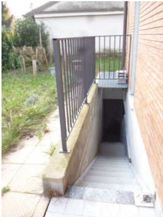
FOTO 12 – Scala di accesso al vano cantina dal giardino di pertinenza
