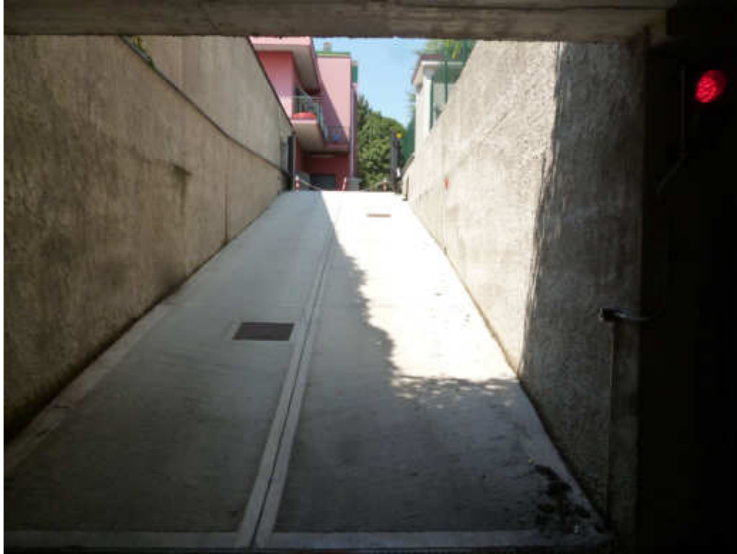
FOTO 3 – Rampa di ingresso ai box
