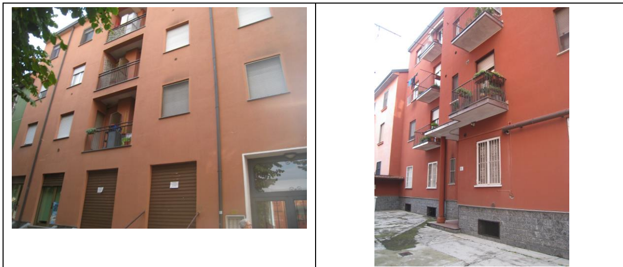
Fig. 4: Edificio fronte strada
