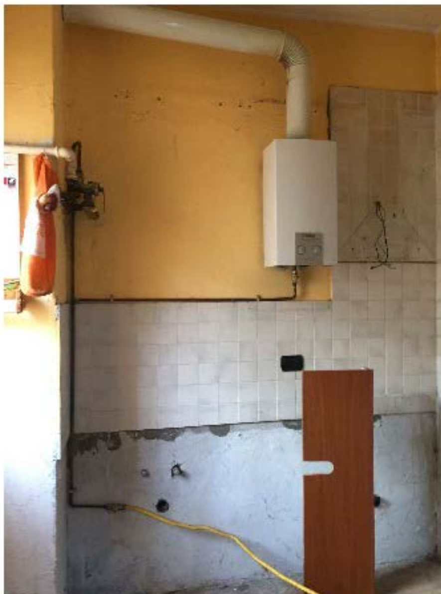
Foto n. 21 - Vista del locale cucina, con particolare dello scaldabagno a gas
