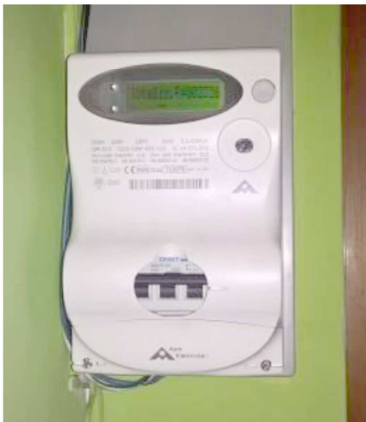
Contatore elettrico
