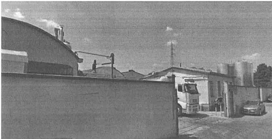
Ingresso su Via Mantova 7
