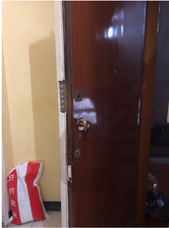
Porta accesso appartamento
