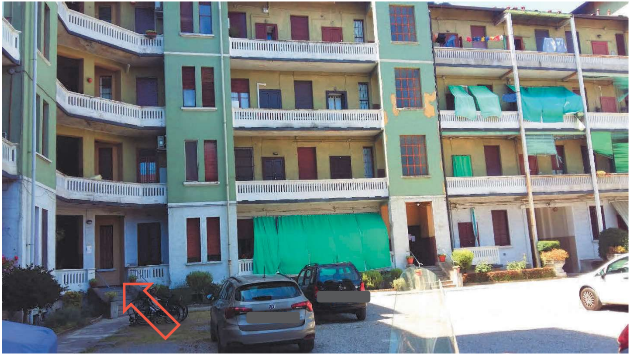
Vista facciata interna
