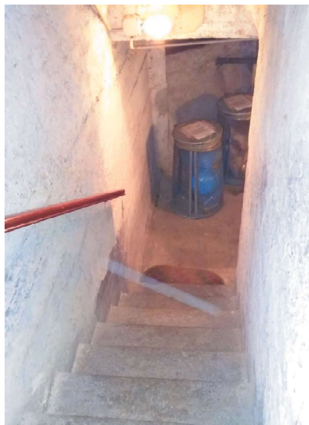
Viste scala accesso cantine
