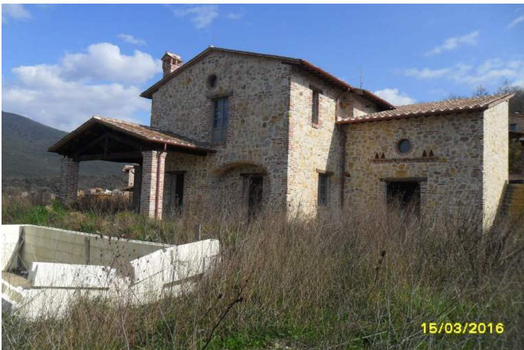
CORPO B - esterno fabbricato
