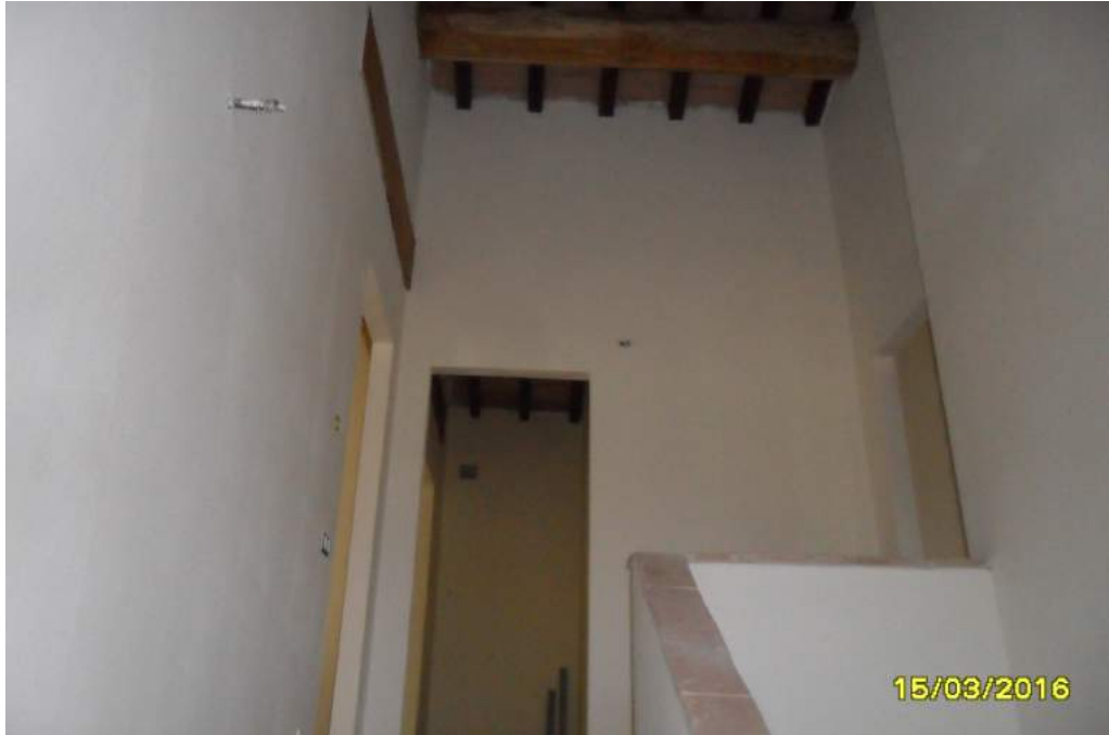
CORPO F - interno fabbricato
