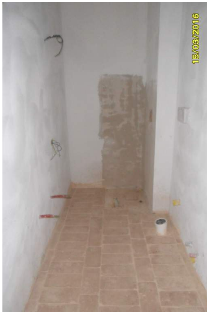
CORPO A - interno fabbricato
