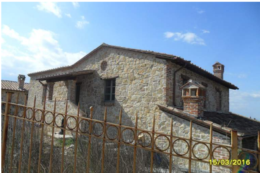
CORPO B - esterno fabbricato
