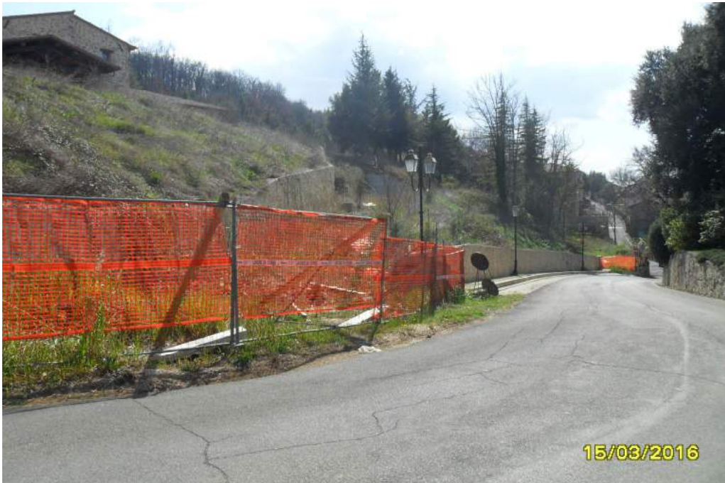
opere urbanizzazione lottizzazione (dalla via San Rocco)
