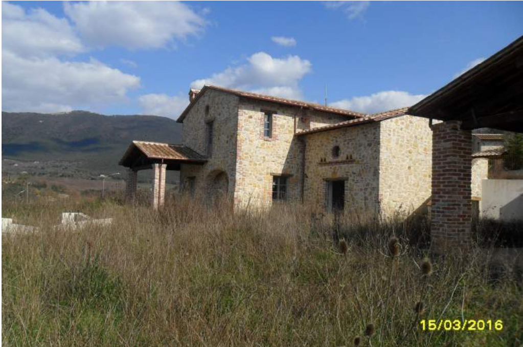
CORPO B - esterno fabbricato
