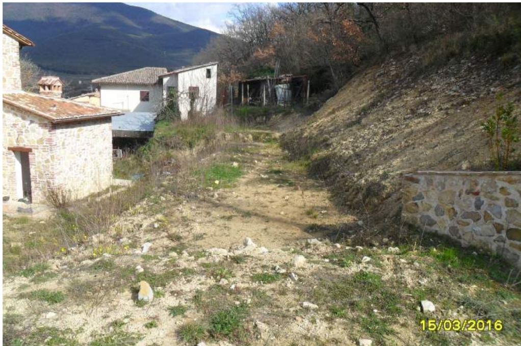
CORPO F - esterno fabbricato (vista opere sistemazione terreno lato sud-est)
