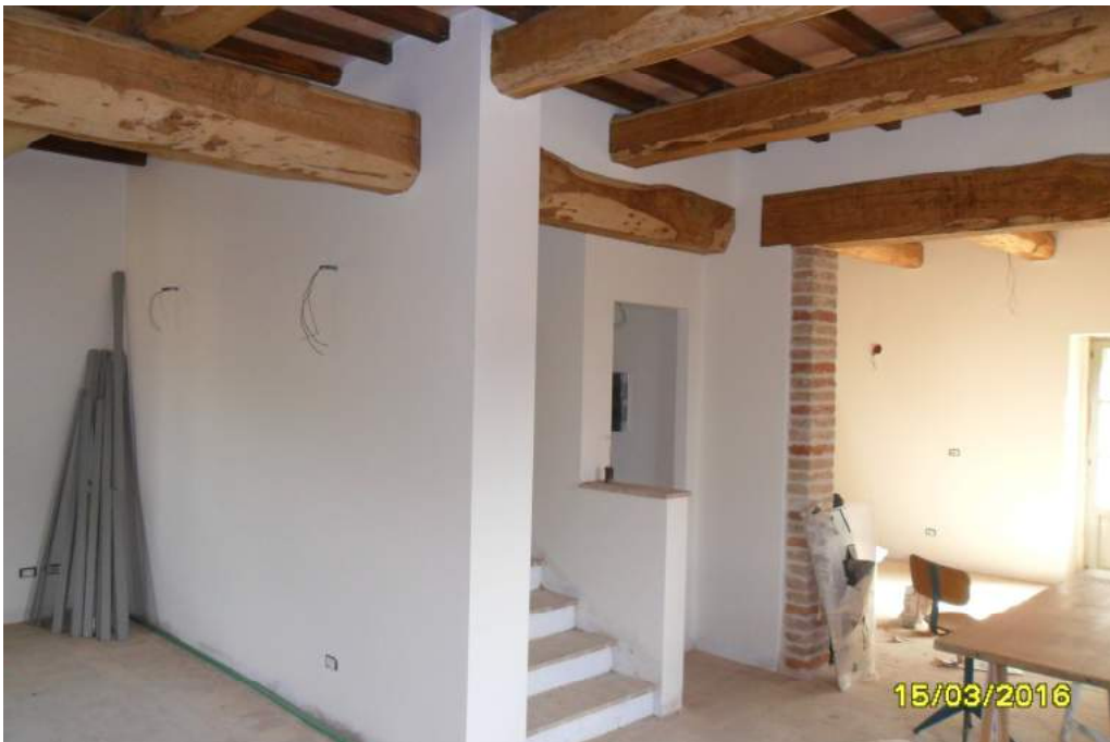
CORPO F - interno fabbricato
