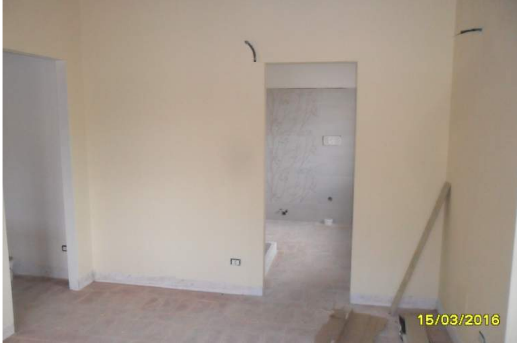
CORPO F - interno fabbricato
