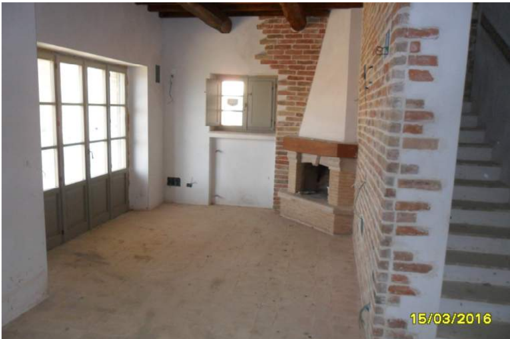
CORPO C - interno fabbricato
