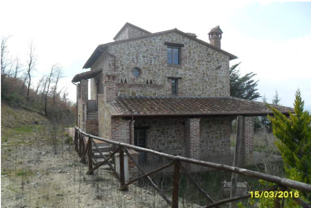
CORPO D - esterno fabbricato
