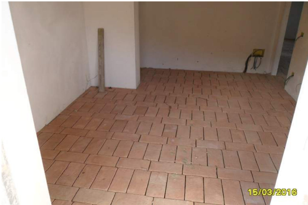
CORPO B - interno fabbricato
