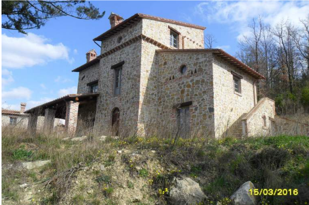
CORPO D - esterno fabbricato
