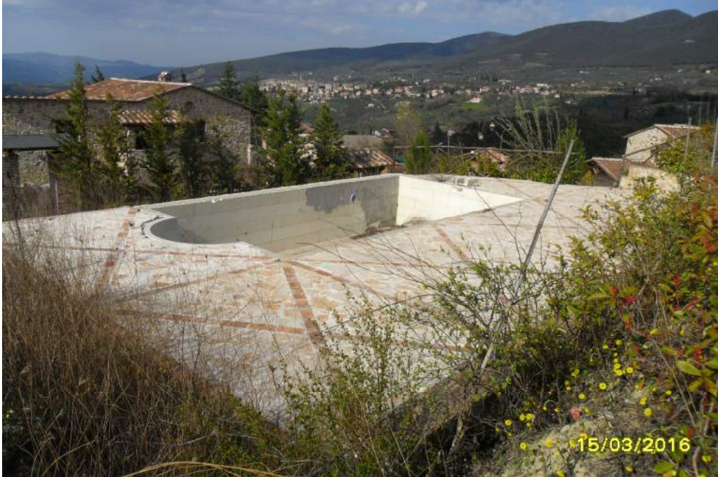
CORPO E - esterno fabbricato
