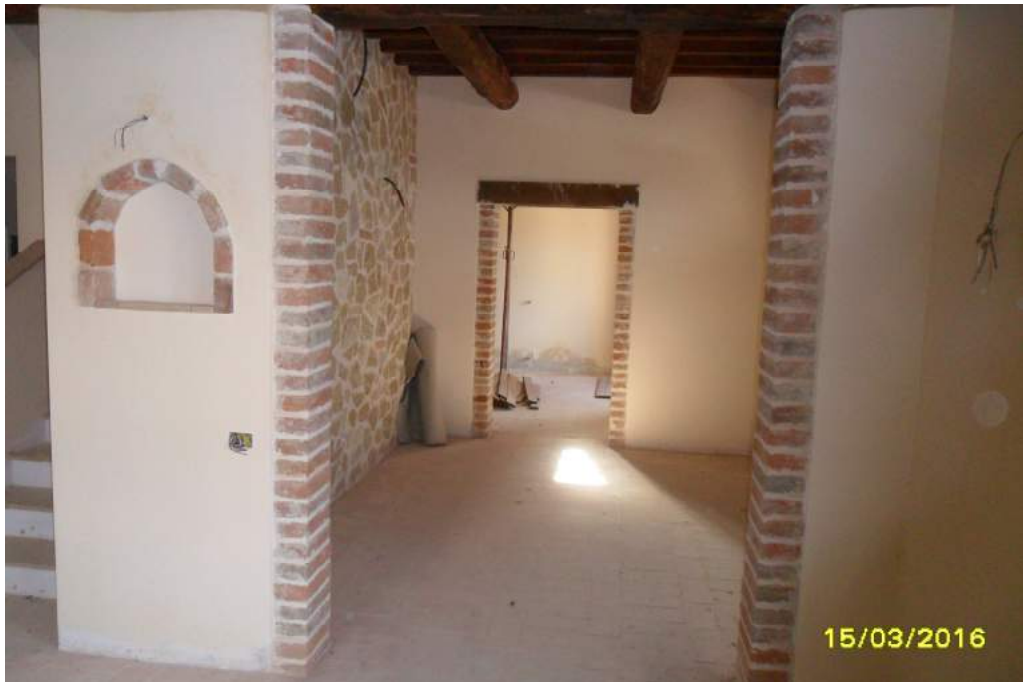
CORPO D - interno fabbricato
