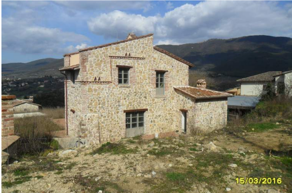
CORPO F - esterno fabbricato
