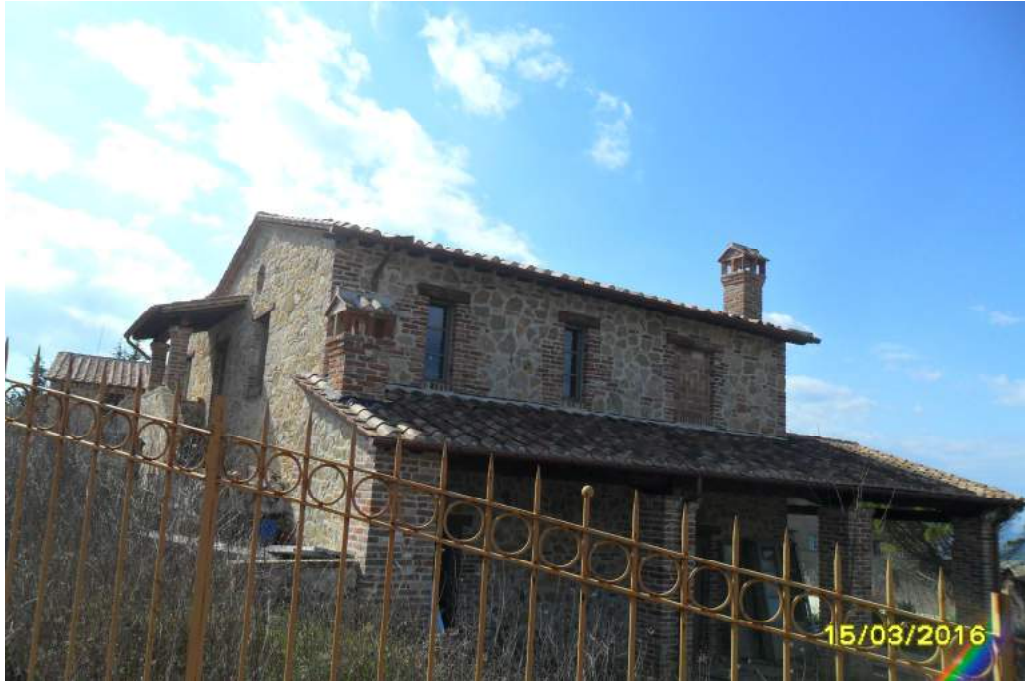
CORPO B - esterno fabbricato
