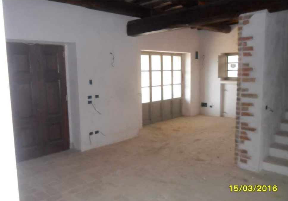
CORPO C - interno fabbricato
