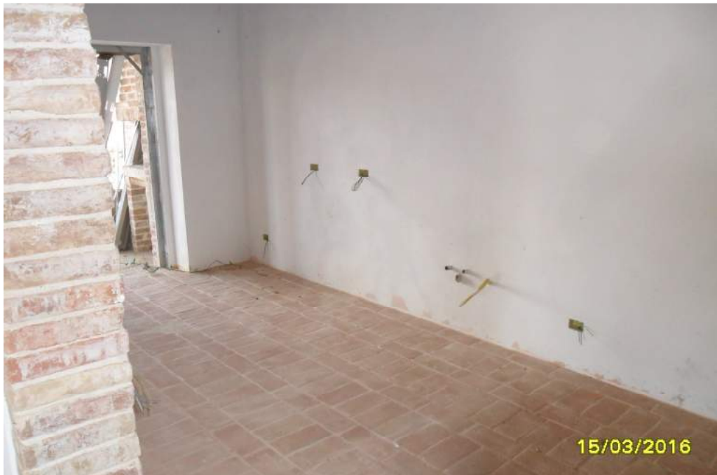
CORPO B - interno fabbricato
