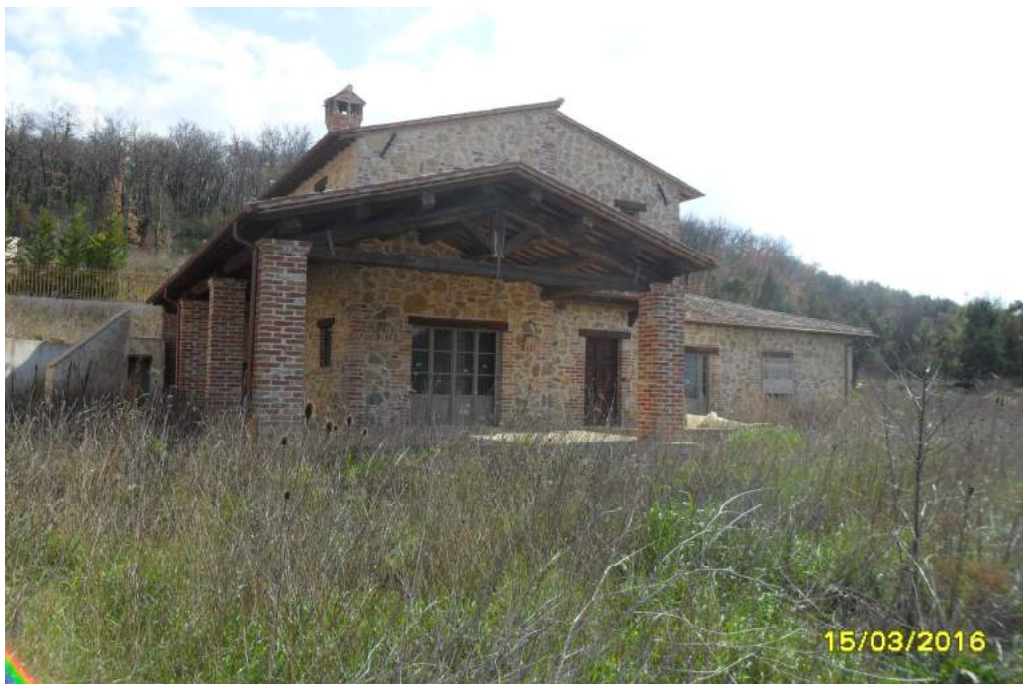
CORPO C - esterno fabbricato
