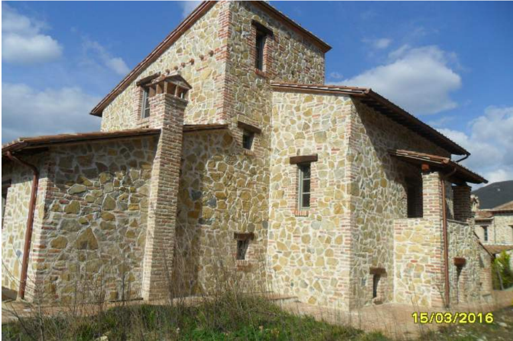
CORPO D - esterno fabbricato
