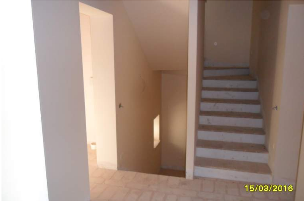
CORPO D - interno fabbricato
