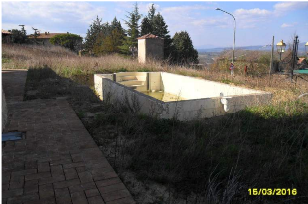
CORPO A - esterno fabbricato
