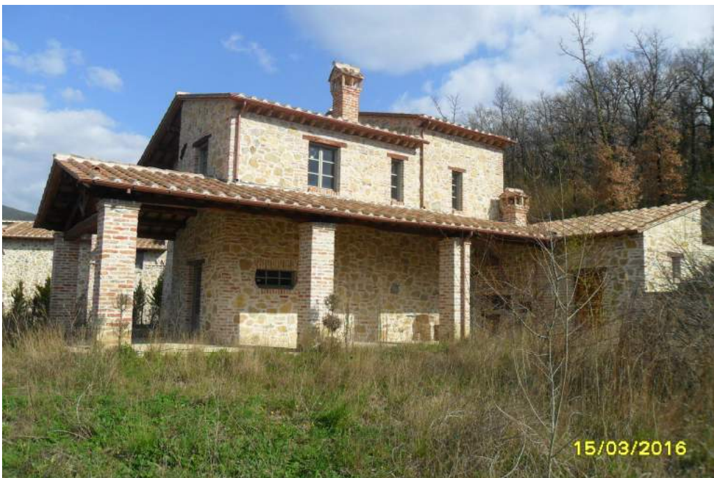
CORPO E - esterno fabbricato
