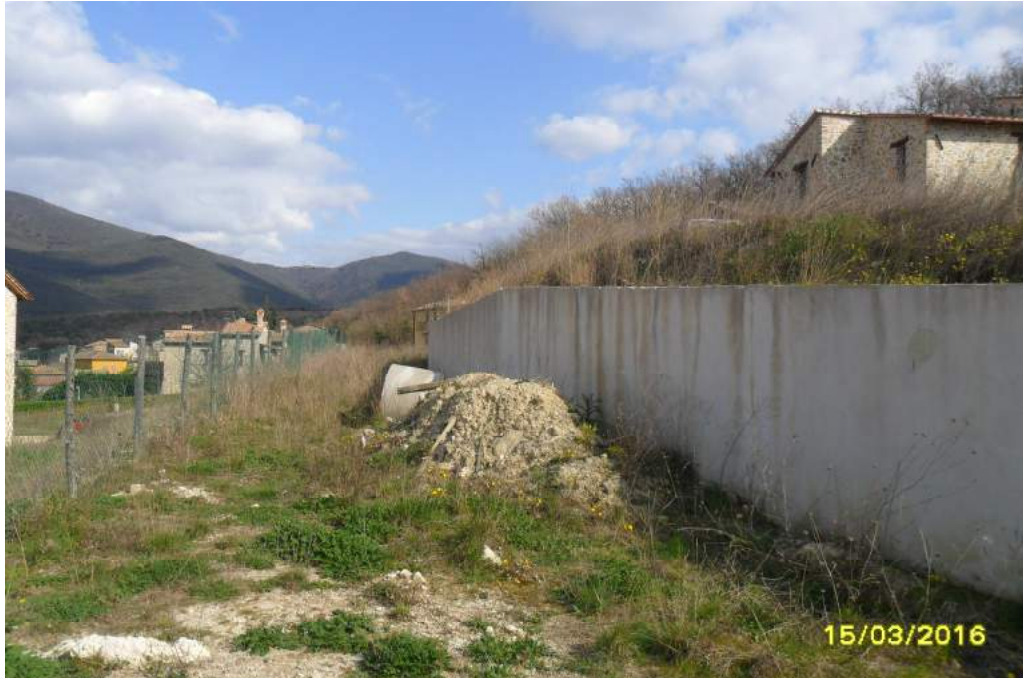
CORPO F - esterno fabbricato
