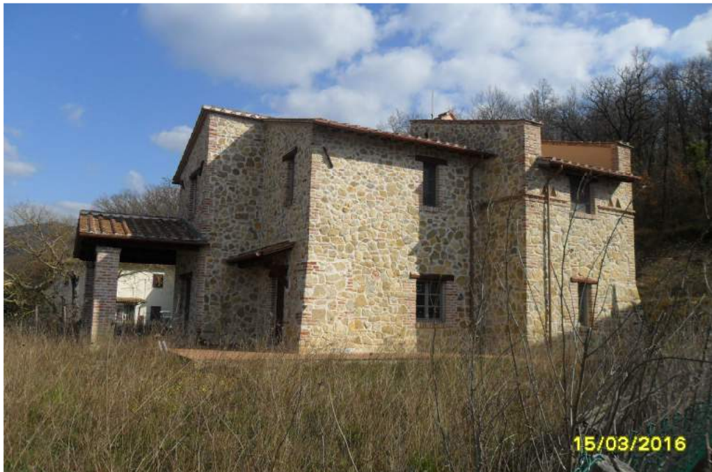
CORPO F - esterno fabbricato
