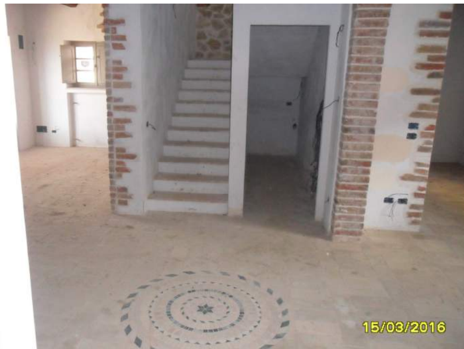
CORPO C - interno fabbricato
