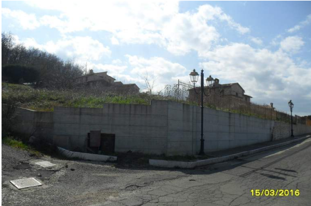
opere urbanizzazione lottizzazione (dalla via San Rocco)
