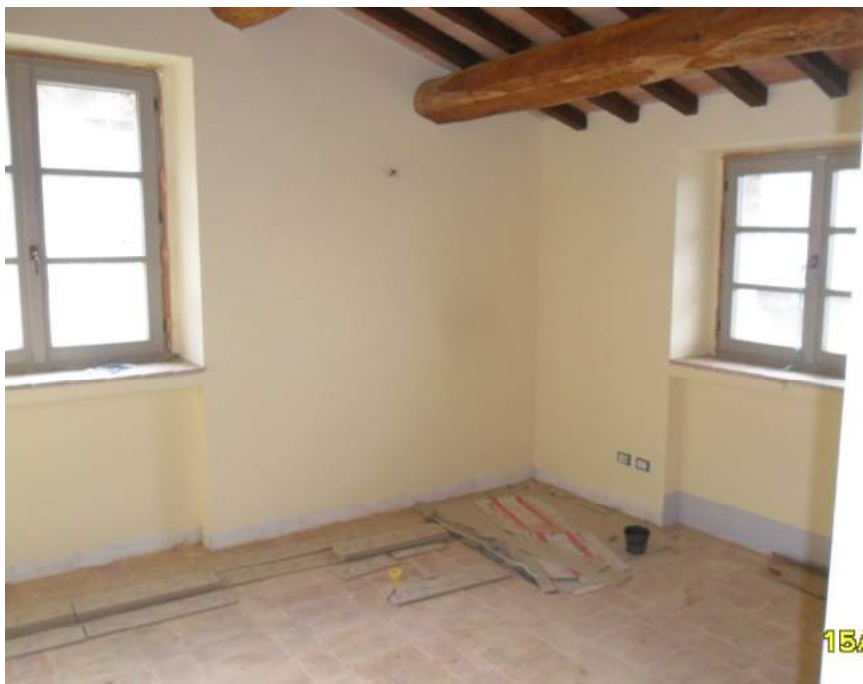
CORPO F - interno fabbricato
