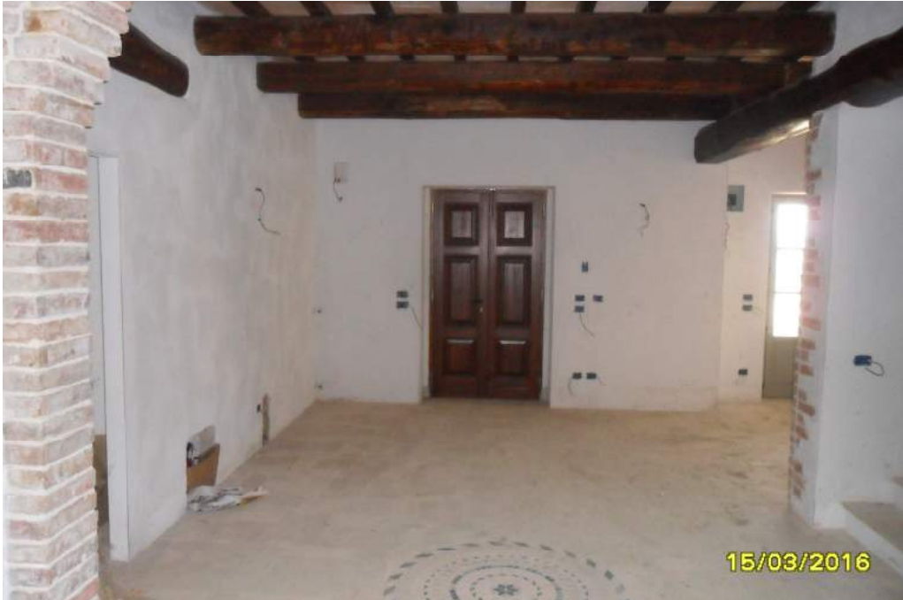
CORPO C - interno fabbricato
