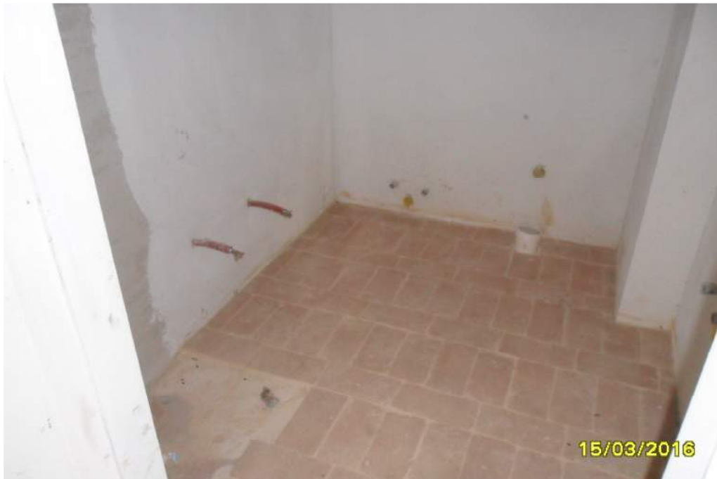
CORPO A - interno fabbricato
