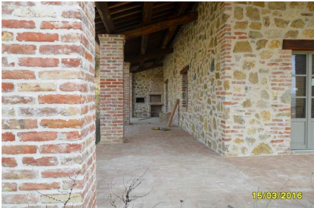
CORPO F - esterno fabbricato
