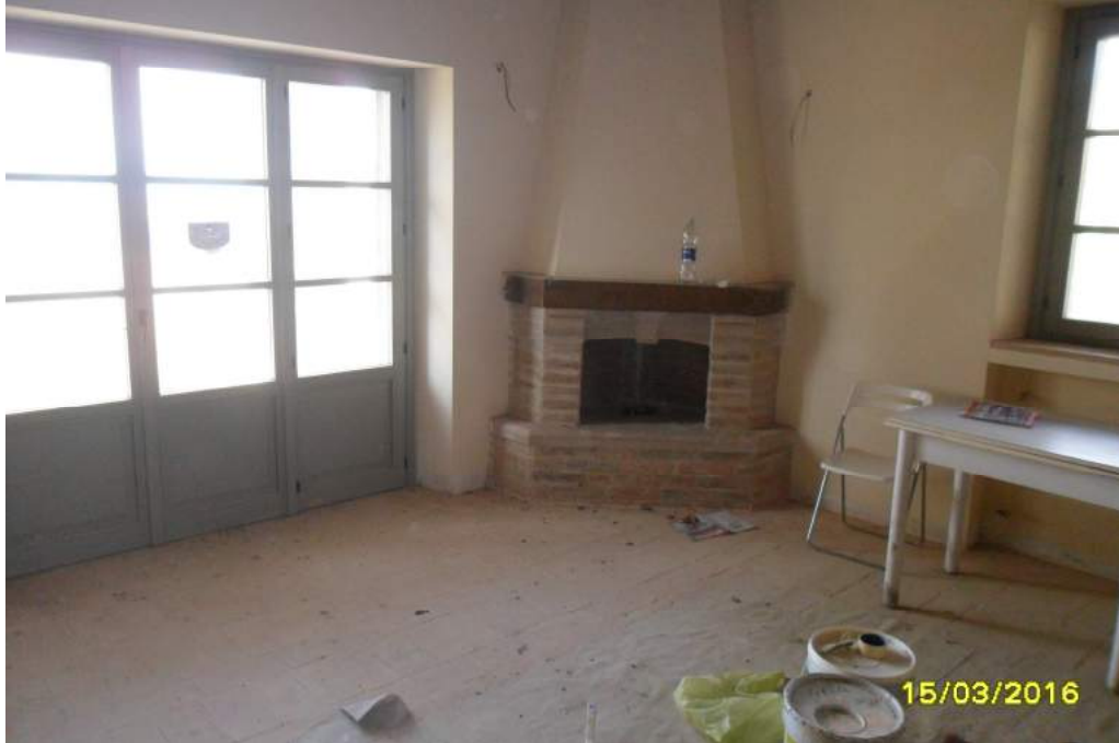
CORPO D - interno fabbricato
