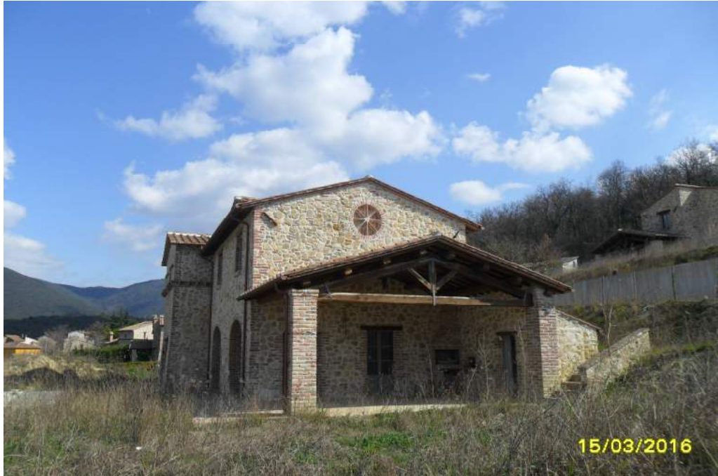
CORPO A - esterno fabbricato
