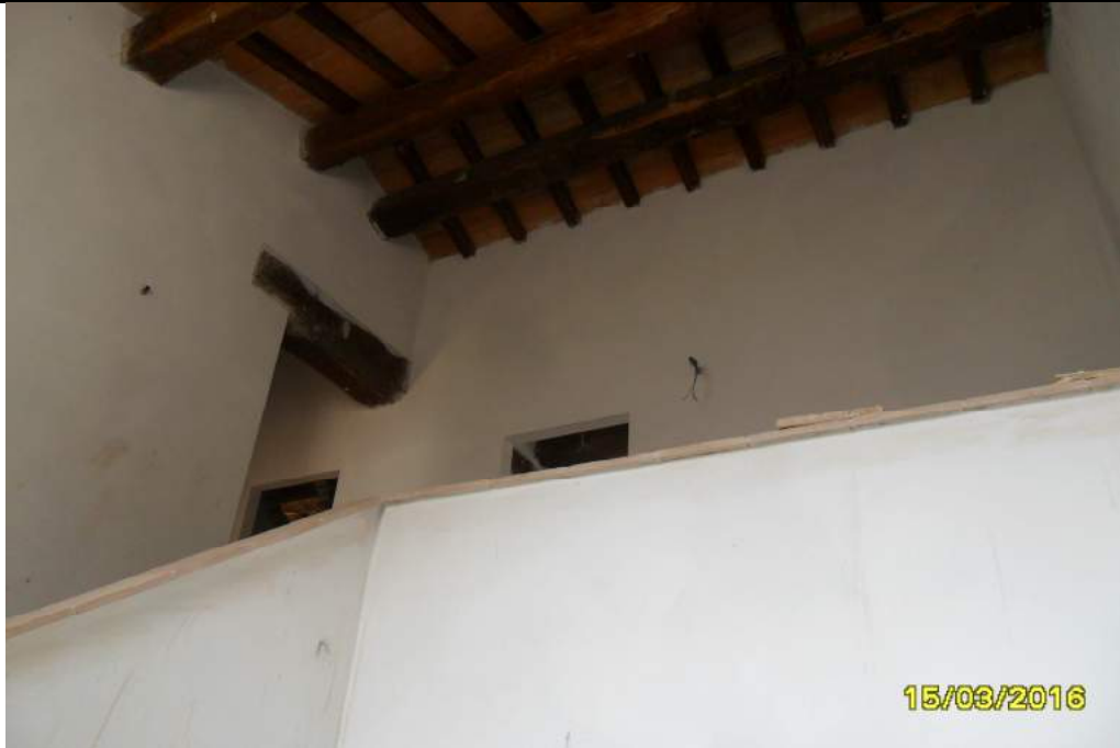
CORPO A - interno fabbricato
