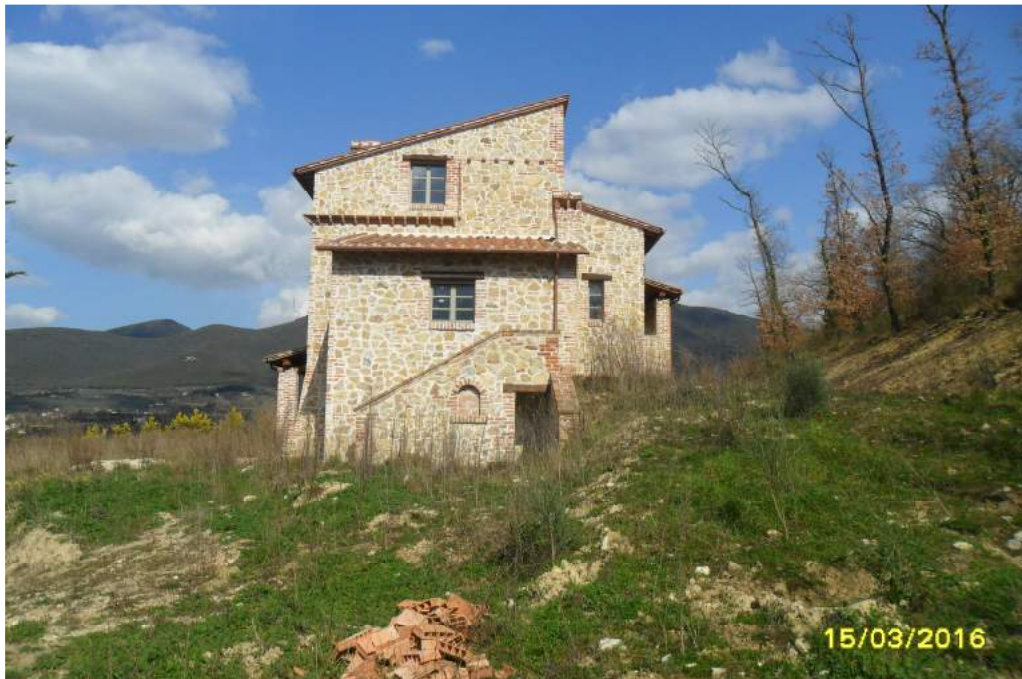
CORPO D - esterno fabbricato (vista opere sistemazione terreno lato sud-est)
