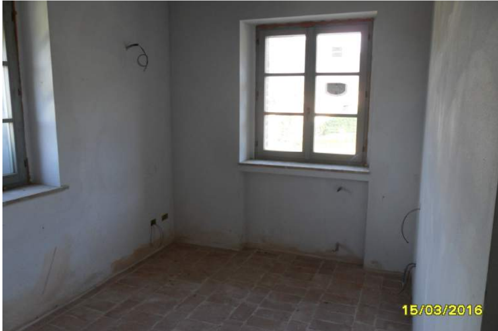
CORPO A - interno fabbricato
