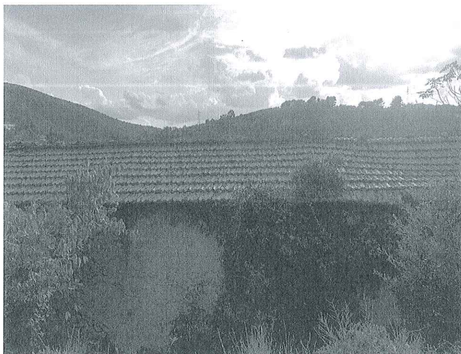
PROSPETTO EST – RUDERE PART. 223 – FOTO N. 3
