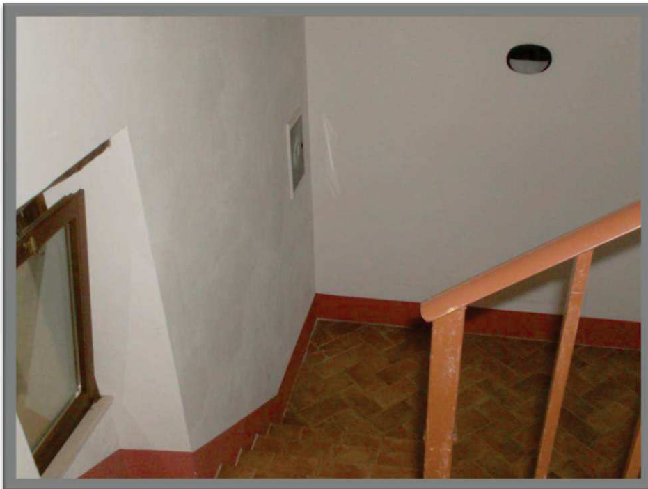
Vano scala comune ai Sub. 9 e Sub. 11
