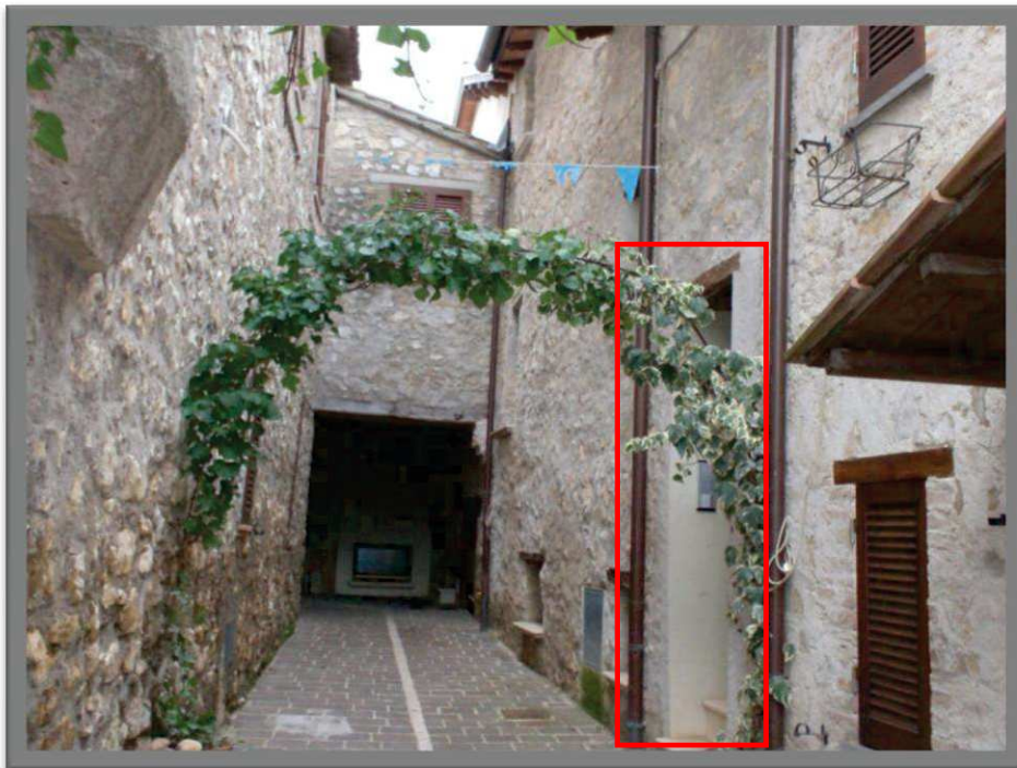
Prospetto Nord dell'edificio con vista del portone di accesso al Sub. 9 e al Sub. 11
