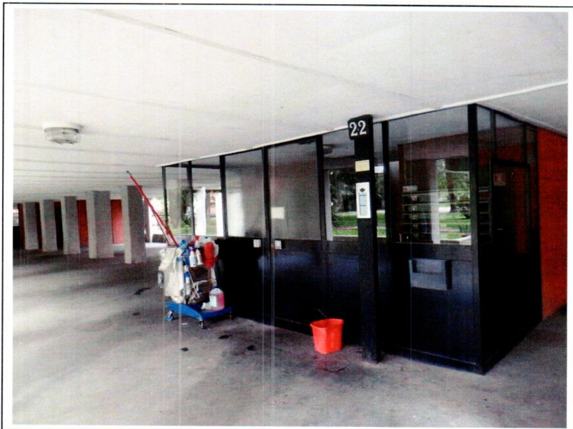
Fotografia n°2 – Vista dell'accesso al fabbricato residenziale.
