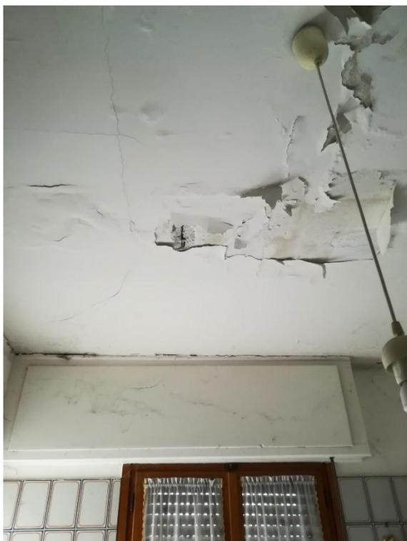
Foto n.10 – Esfoliazioni tinta e ferri struttura solaio del locale cucina
