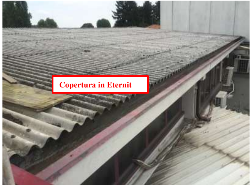
viste dal balcone
