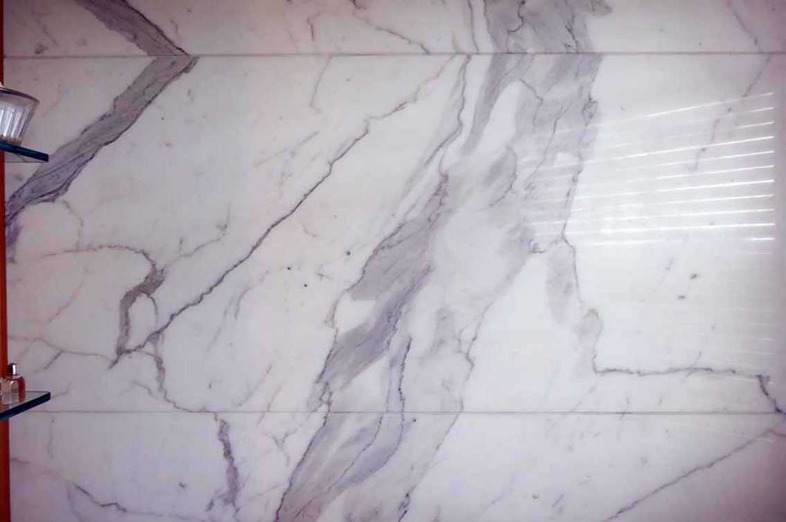
Bagno padronale. Particolare del rivestimento in marmo a parete, con le lastre di grande formato abbinata
