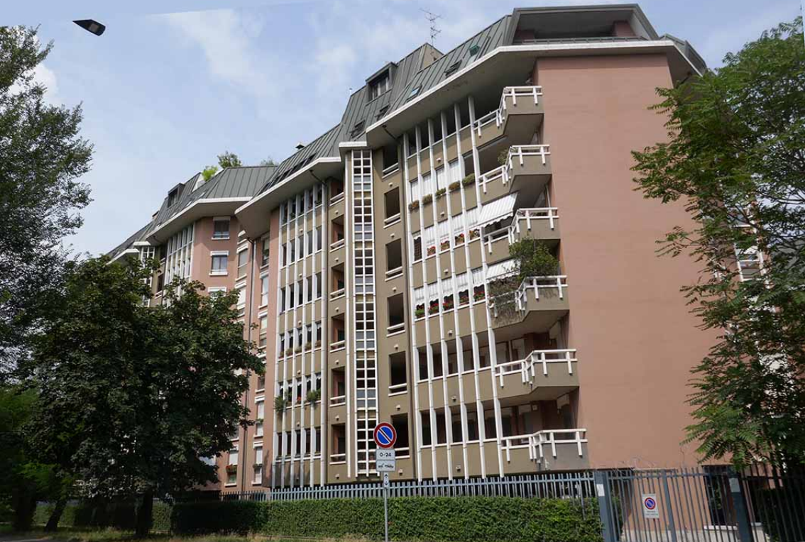
Prospetto lungo via Pinerolo
