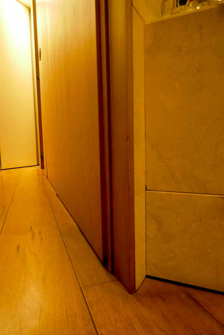
Secondo bagno. Dettaglio delle finiture.
