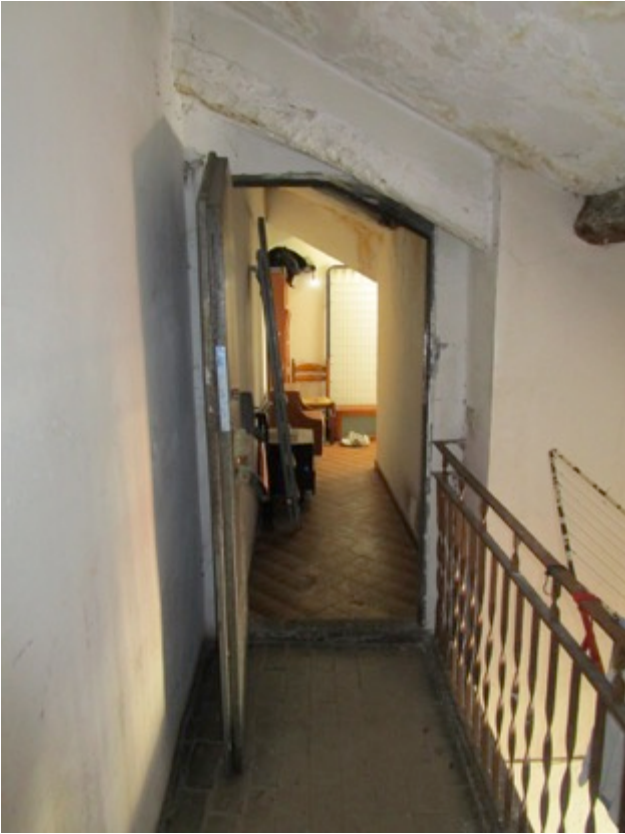
13. Porta di accesso al vano solai nel sottotetto.
