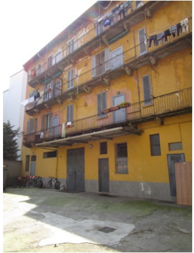
Vista del fabbricato dal cortile interno, lato sud.
