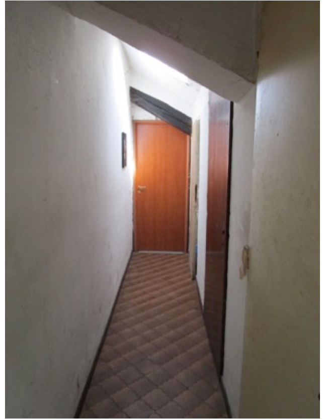
14. Corridoio comune, accesso ai solai.
