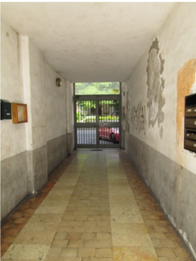
Portico carraio di accesso al fabbricato.
