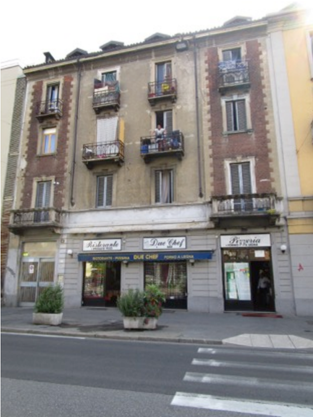
Fabbricato vista dalla strada.
