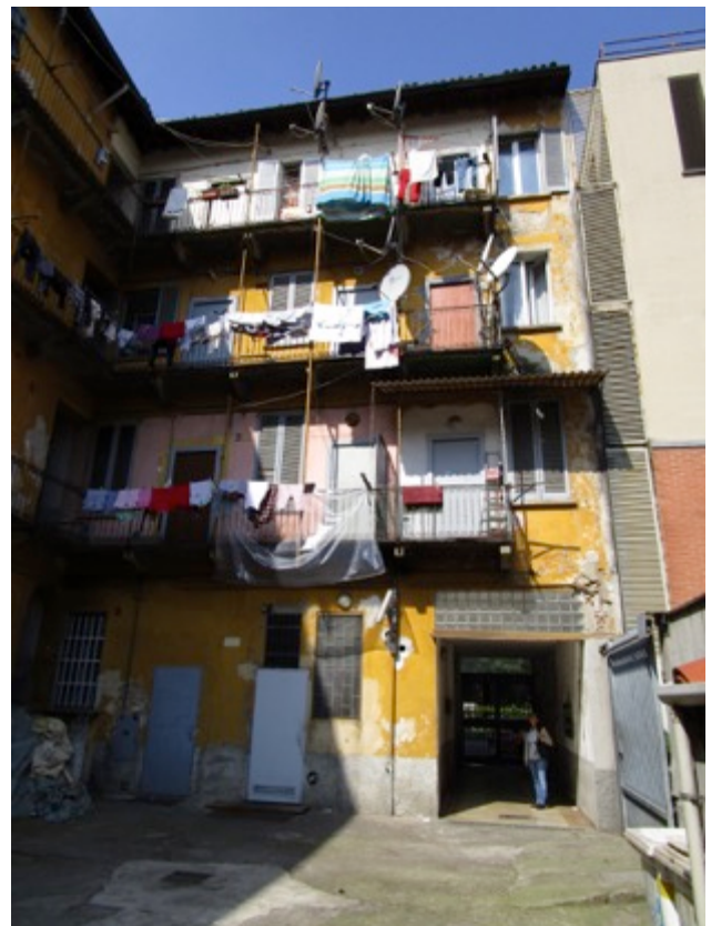
Vista del fabbricato dal cortile interno, lato ovest.
