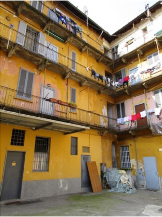
Vista del fabbricato dal cortile interno.
