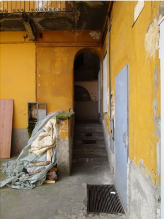
Accesso alla scala condominiale dal cortile.
