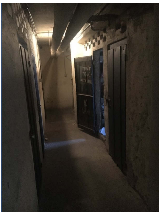
Foto 45 - corridoio comune piano S1
