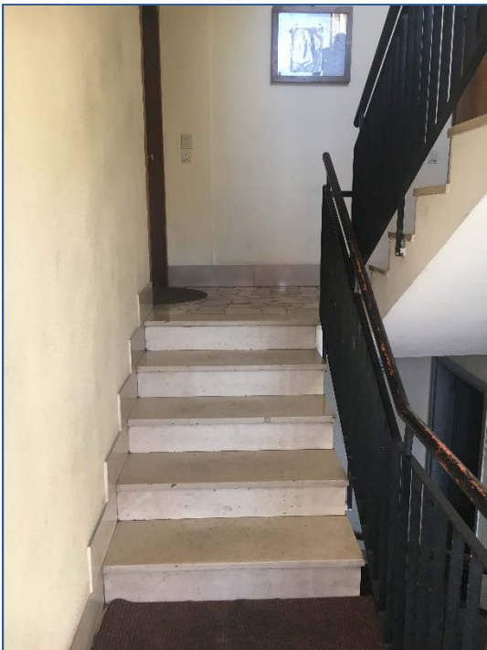
Foto 11 - vano scala comune
