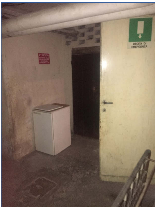
Foto 47 - corridoio comune piano S1
