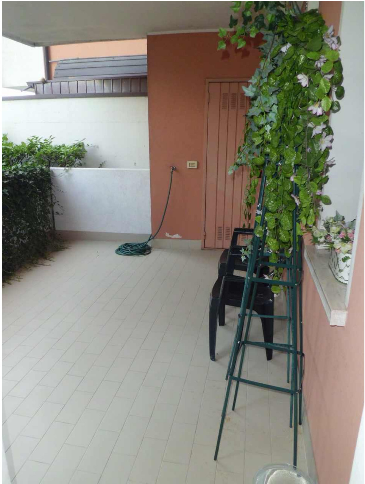
Foto n° 15 - 28/08/2017 - Comune di Porcia, foglio 3, part. 1344, sub.3 - Terrazza esterna. Sullo sfondo visibile la porta che permette l'accesso alla centrale termica/ripostiglio. Sulla sinistra è visibile il muretto di confine con il sub. 82.
