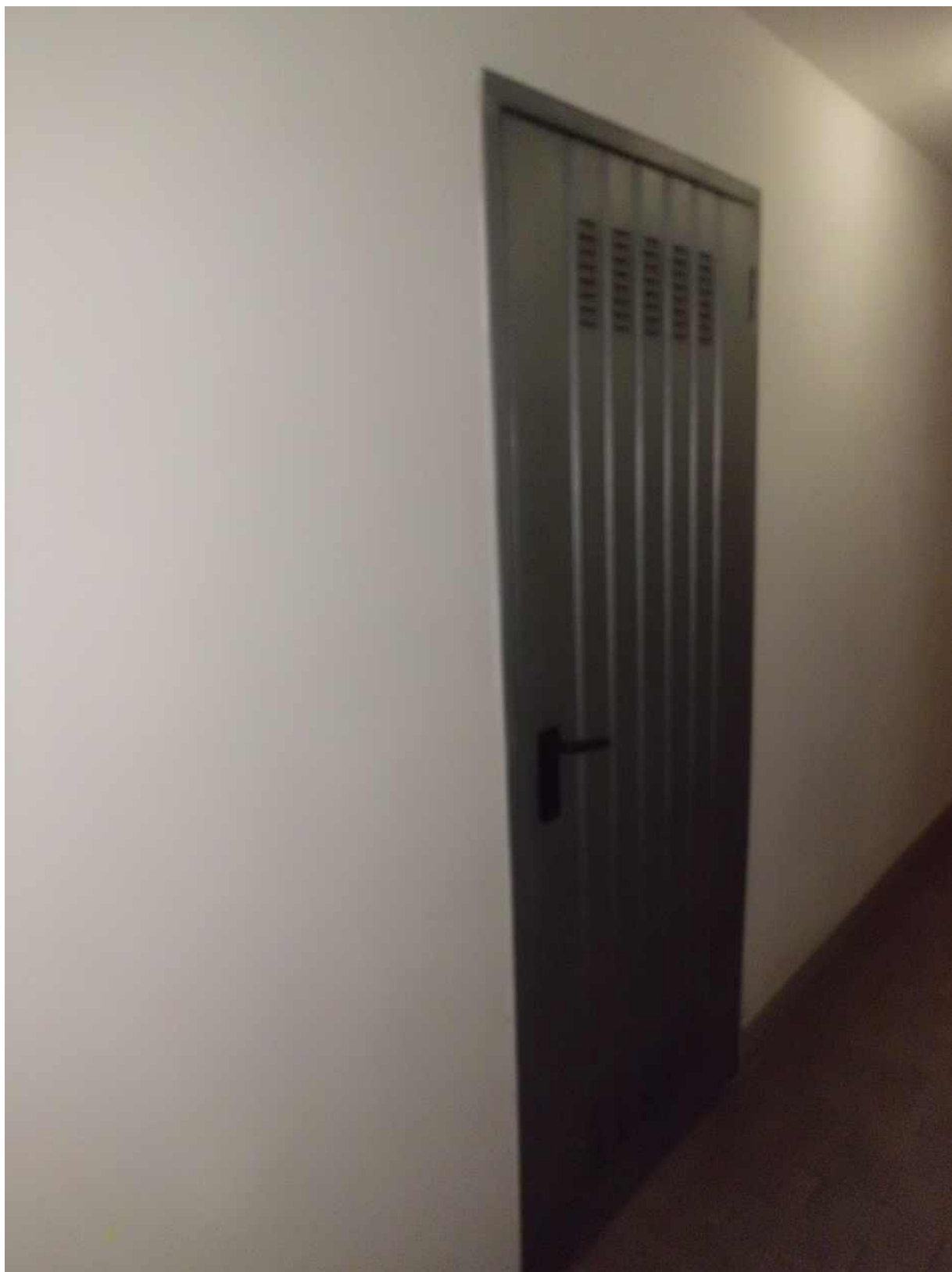
Foto n° 20 - 28/08/2017 - Comune di Porcia, foglio 3, part. 1344, sub.37 – Porta che immette nella cantina. Fotografia scattata dal corridoio condominiale.
