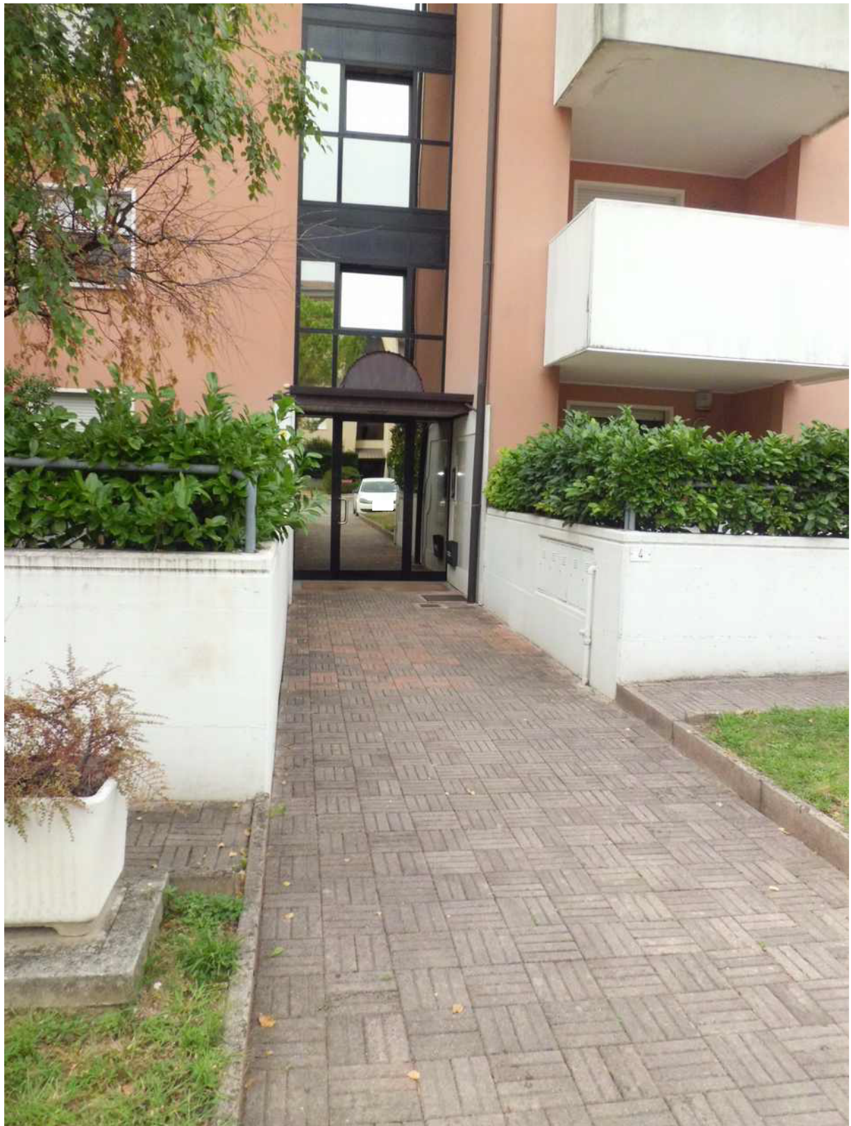
Foto n° 2 - 28/08/2017 - Comune di Porcia, foglio 3, part. 1344 - Portone di ingresso al condominio.
