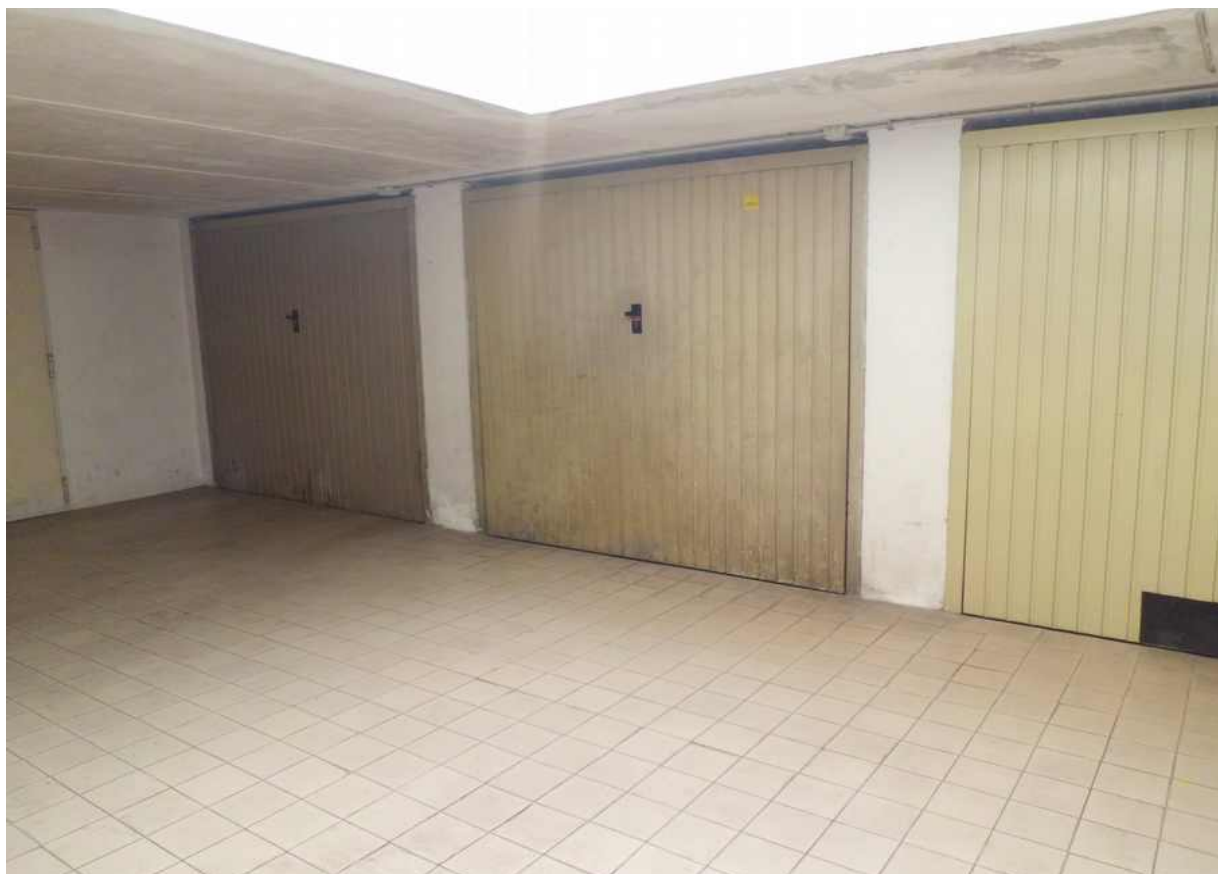
Foto n° 22 - 28/08/2017 - Comune di Porcia, foglio 3, part. 1344, sub.63 – Autorimessa. Fotografia scattata dall'area di manovra condominiale.
