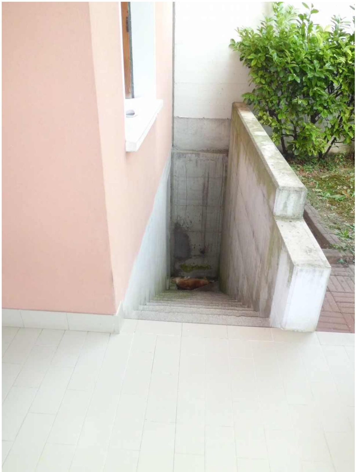
Foto n° 17 - 28/08/2017 - Comune di Porcia, foglio 3, part. 1344, sub.3 – Terrazza esterna. Scale che conducono alla cantina identificata al sub.37. Sulla destra visibile l'accesso al cortile ricadente nel sub.82
