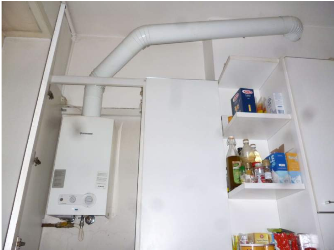
FOTO 13 – Scaldabagno a gas
