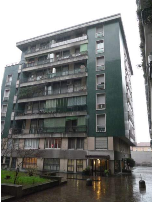
FOTO 1 – Edificio sito in Milano, Via Giambellino 57/Via Giacinto Bruzzesi 37 con accesso pedonale dal cortile comune
