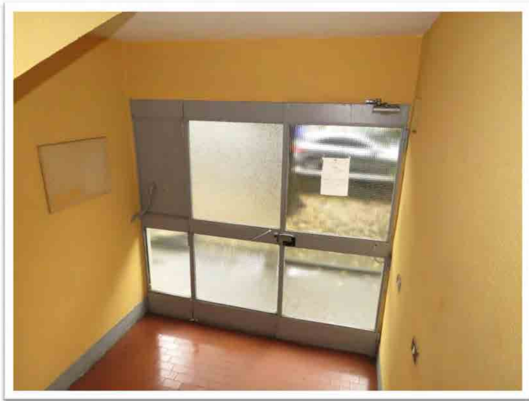
Particolare dell'ingresso e del vano scala E.
