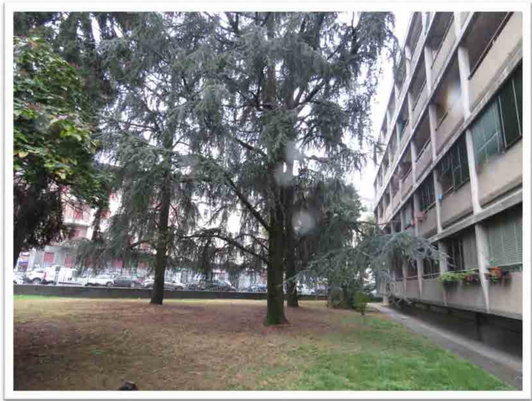
Il fabbricato e l'ingresso al vano scala E.
