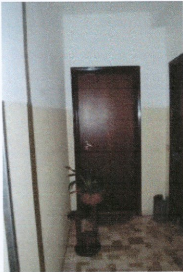
Foto 1. Porta d'accesso all'appartamento
