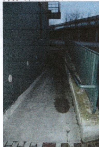
Foto 10. Rampa d'accesso alle cantine
