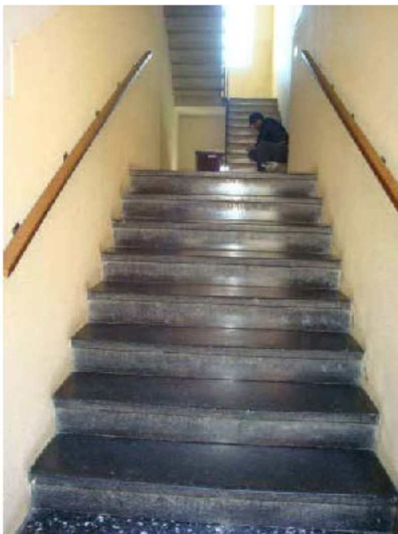
FOTO 12 – Dettaglio del vano scala comune
