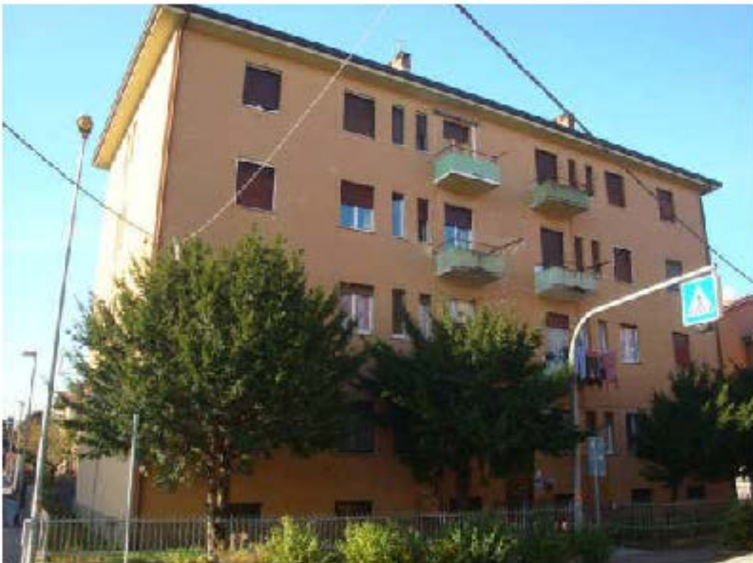
FOTO 4 – Facciata del fabbricato in affaccio sulla Via Pieregrosso
