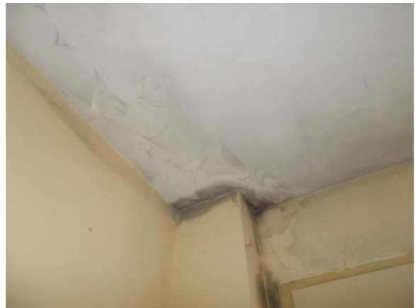
30. Soffitto del bagno
