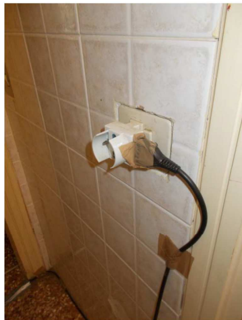
44. Collegamento elettrico
