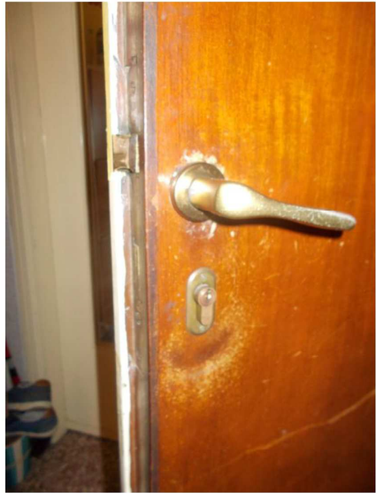
14. Particolare del portoncino di ingresso
