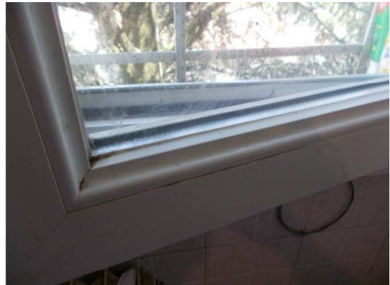
24. Dettaglio serramento della cucina
