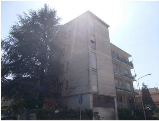
1. Panoramica del fabbricato
