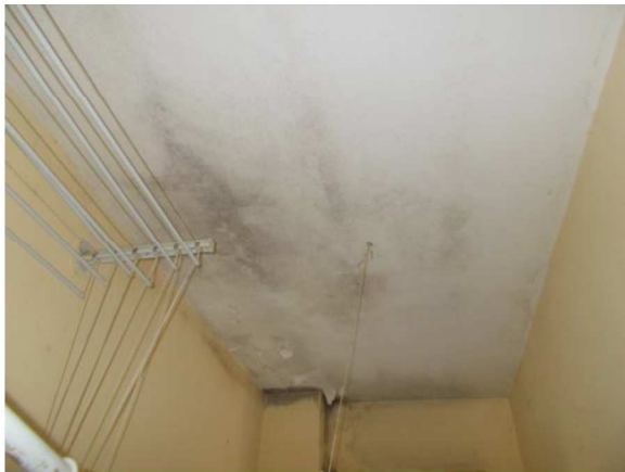
29. Soffitto del bagno
