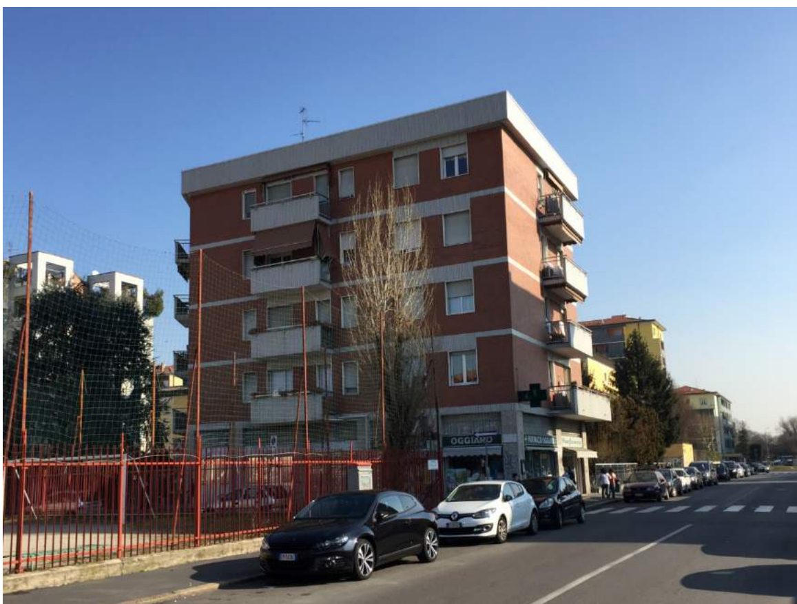
Foto 02 - Il fabbricato su via Trilussa
