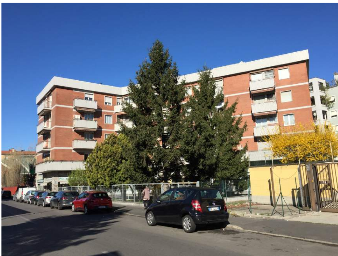
Foto 01 - Il fabbricato su via Trilussa
