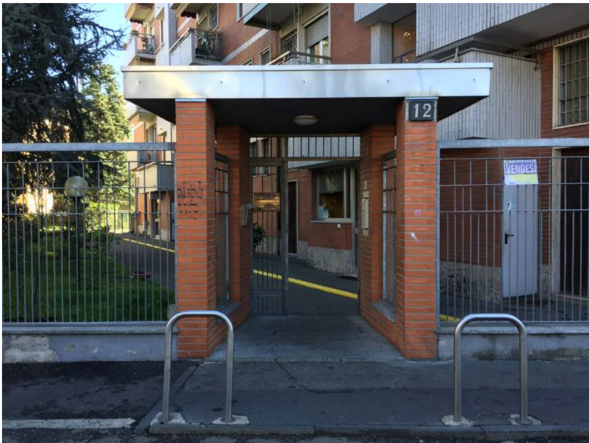
Foto 04 - Accesso al fabbricato al civico 12 di via Ungaretti
