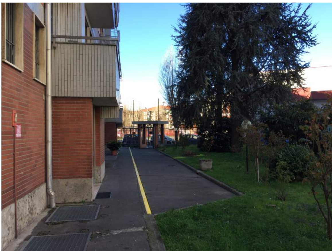
Foto 05 - Vialetto interno nel cortile comune del fabbricato
