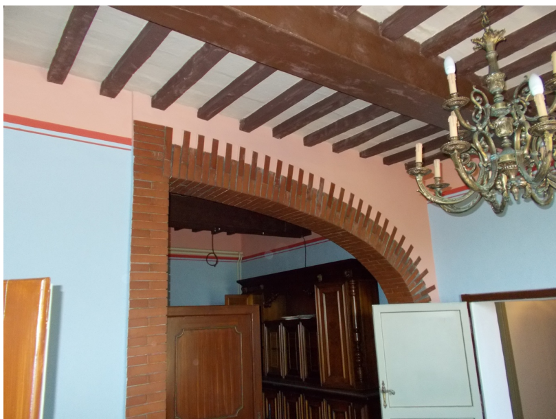
Foto 10 Soggiorno e solaio interpiano
