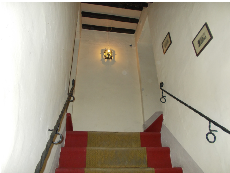
Foto 07 Scale di accesso al piano primo
