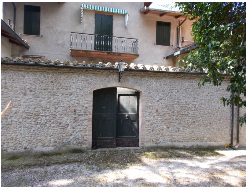
Foto 04 Accesso al cortile comune sul lato nord
