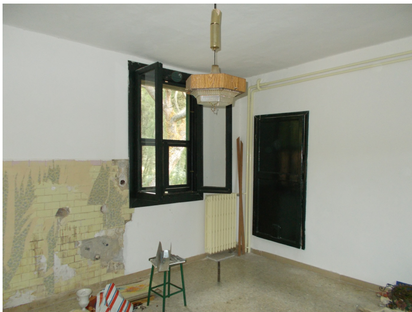
Foto 13 Cucina con accesso al piano terzo
