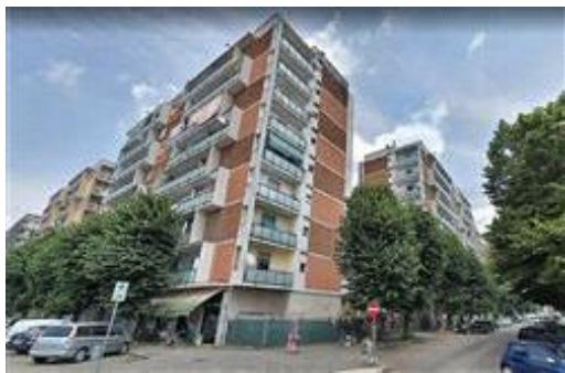
VISTA DA STRADA
