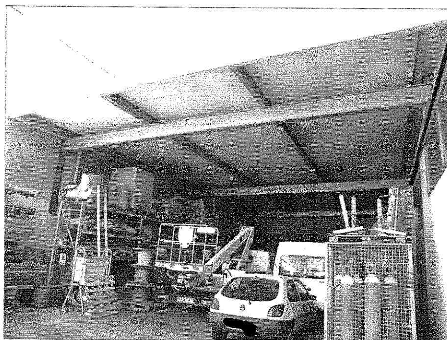
Compendio aziendale - Pordenone, via Roveredo 52/C: tettoia (piano interrato)
