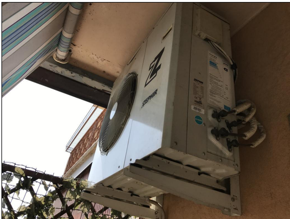
Fig.17: unità di climatizzazione esterna
