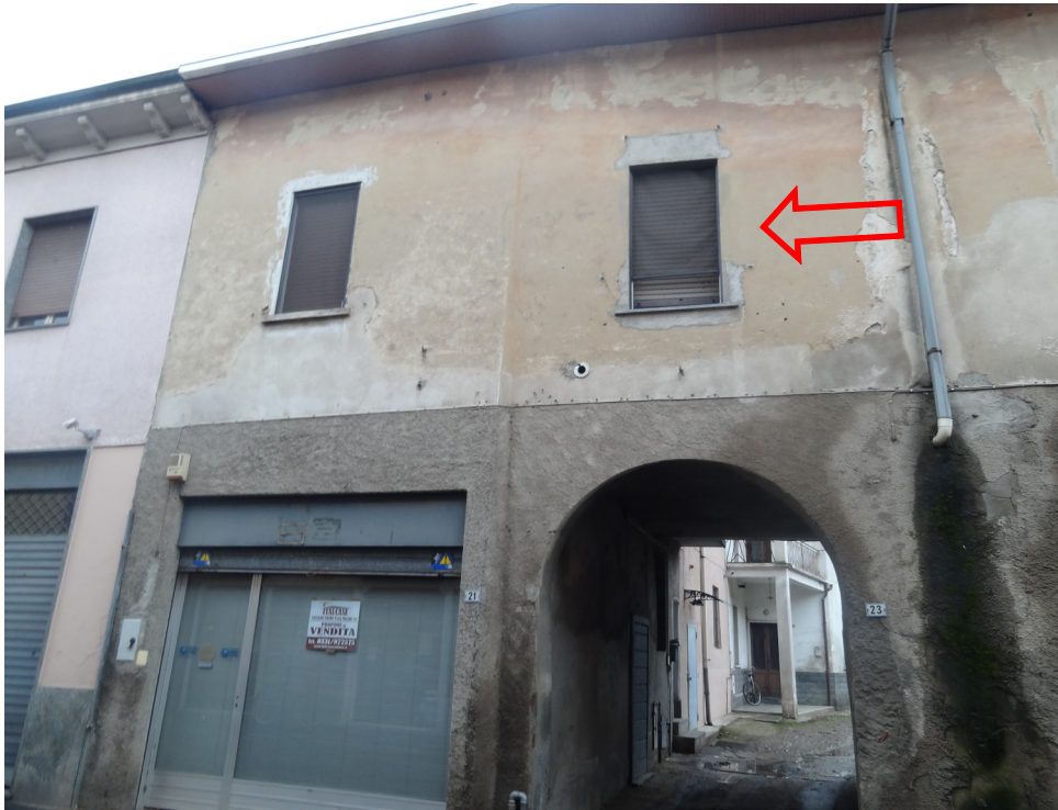
Foto esterna - ingresso corte interna fronte strada
