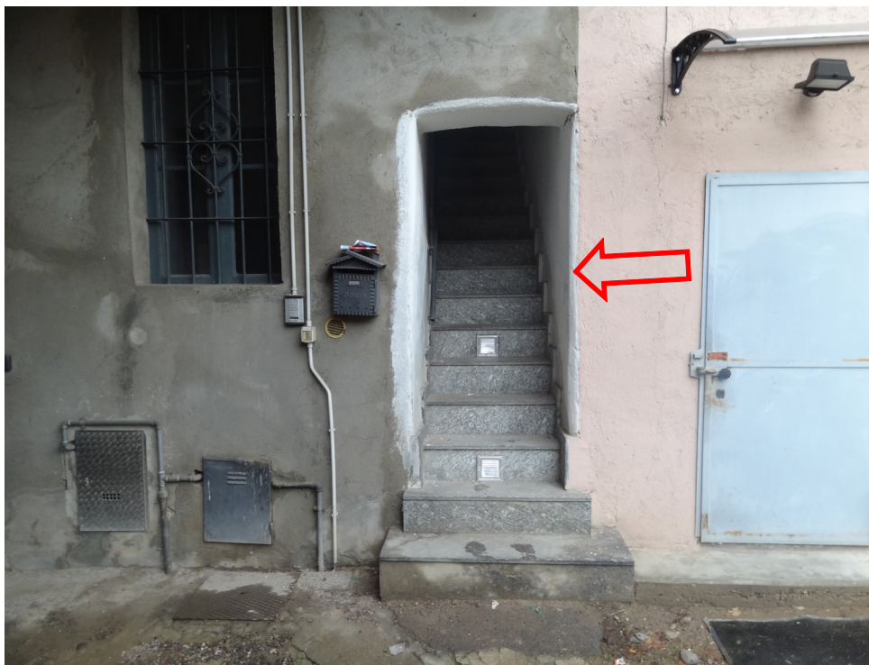
Foto esterna - scala d'accesso al cespite
