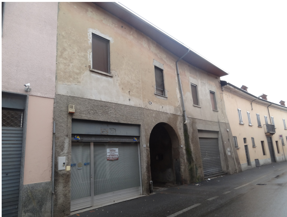
Foto esterna - Palazzina sul fronte strada
