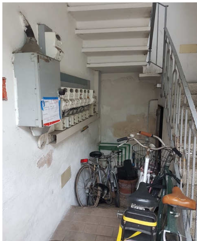
26. la scala di accesso e la porta delle cantine condominiali
