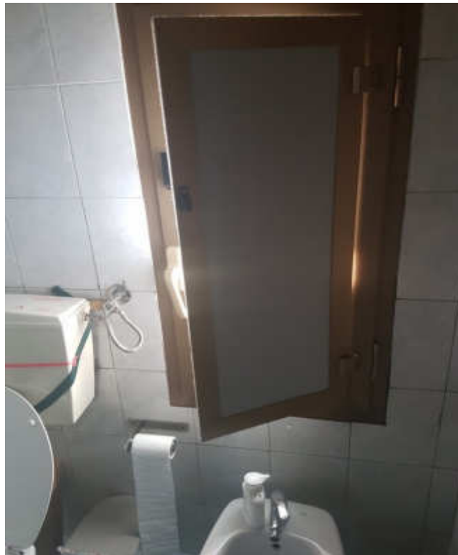
24. particolare della finestra del bagno
