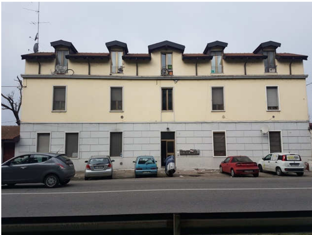
2. veduta frontale dell'edificio in cui è sita l'unità immobiliare pignorata
