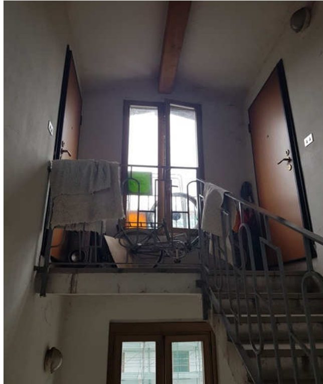
8.il pianerottolo di arrivo all'unità immobiliare pignorata al piano secondo
