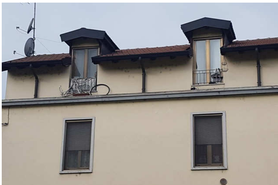
3. porzione del fabbricato in corrispondenza dell'unità immobiliare pignorata
