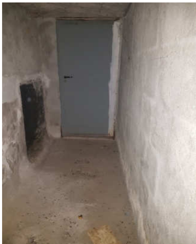
27. il corridoio d'accesso alle cantine condominiali
