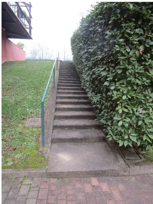
Attraversamento parti comuni
