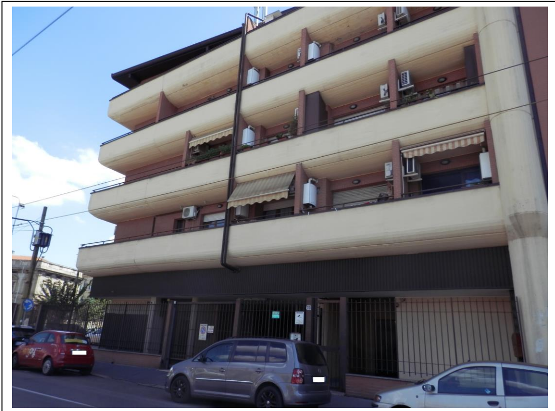
Fotografia n°1 – Vista del fabbricato da Viale Espinasse
