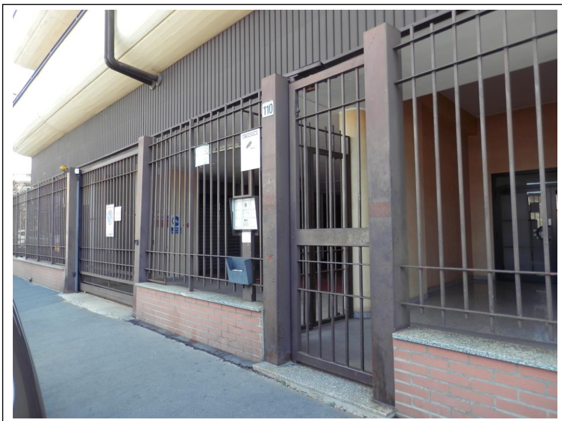
Fotografia n°4 – Vista del cancello d'accesso pedonale al complesso edilizio.
