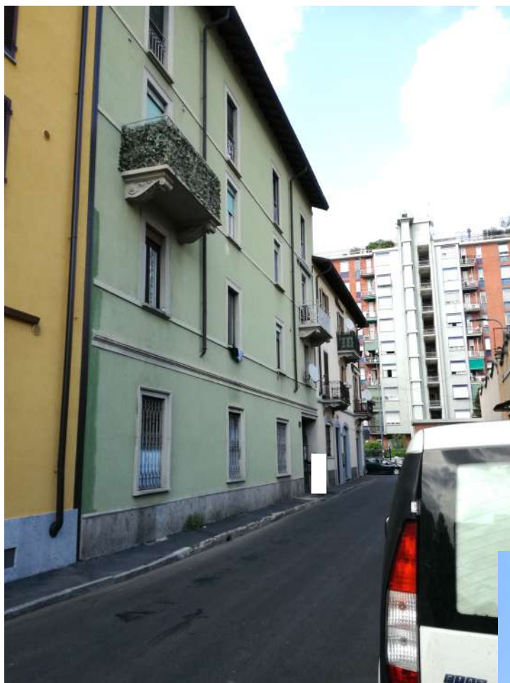
Foto 3,4 - viste esterne insediamento e edificio staggiati
