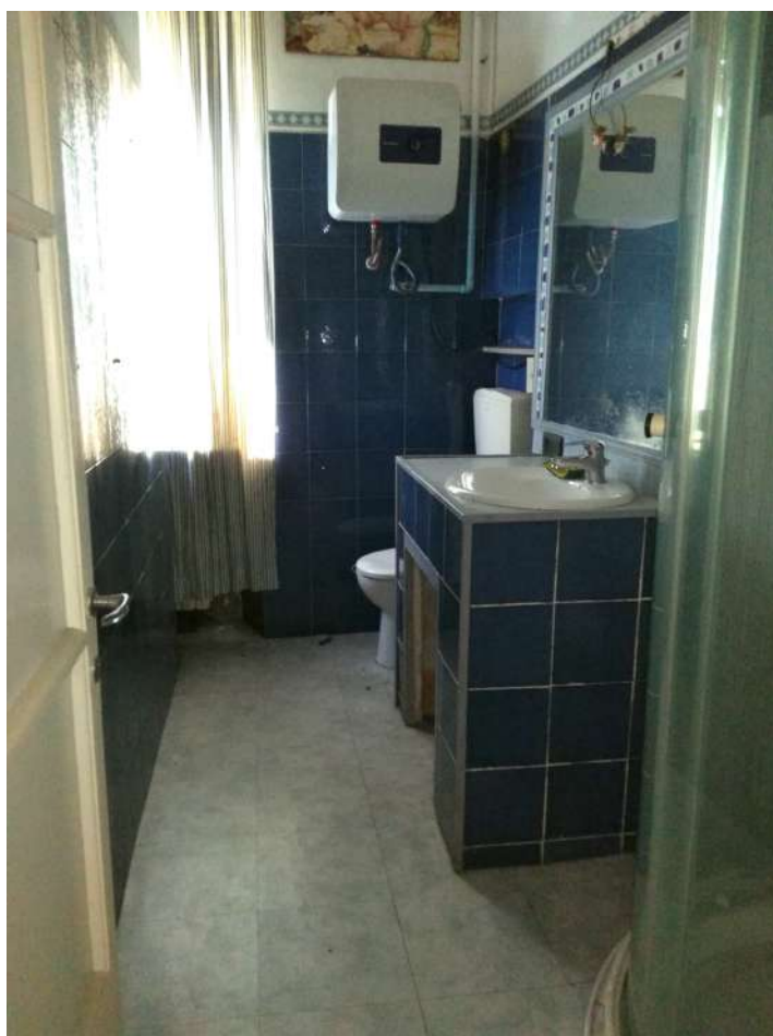
Foto 14, 15 - bagno e scaldabagno elettrico
