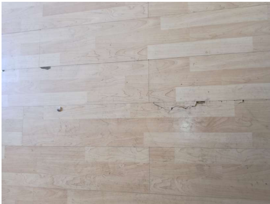
Foto 23 – pavimenti parquet flottante
