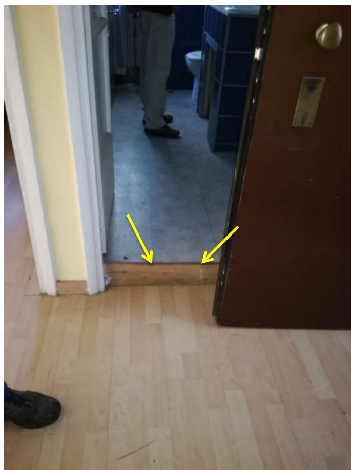
Foto 16 - gradino entrata bagno per ottenimento pendenze doccia
