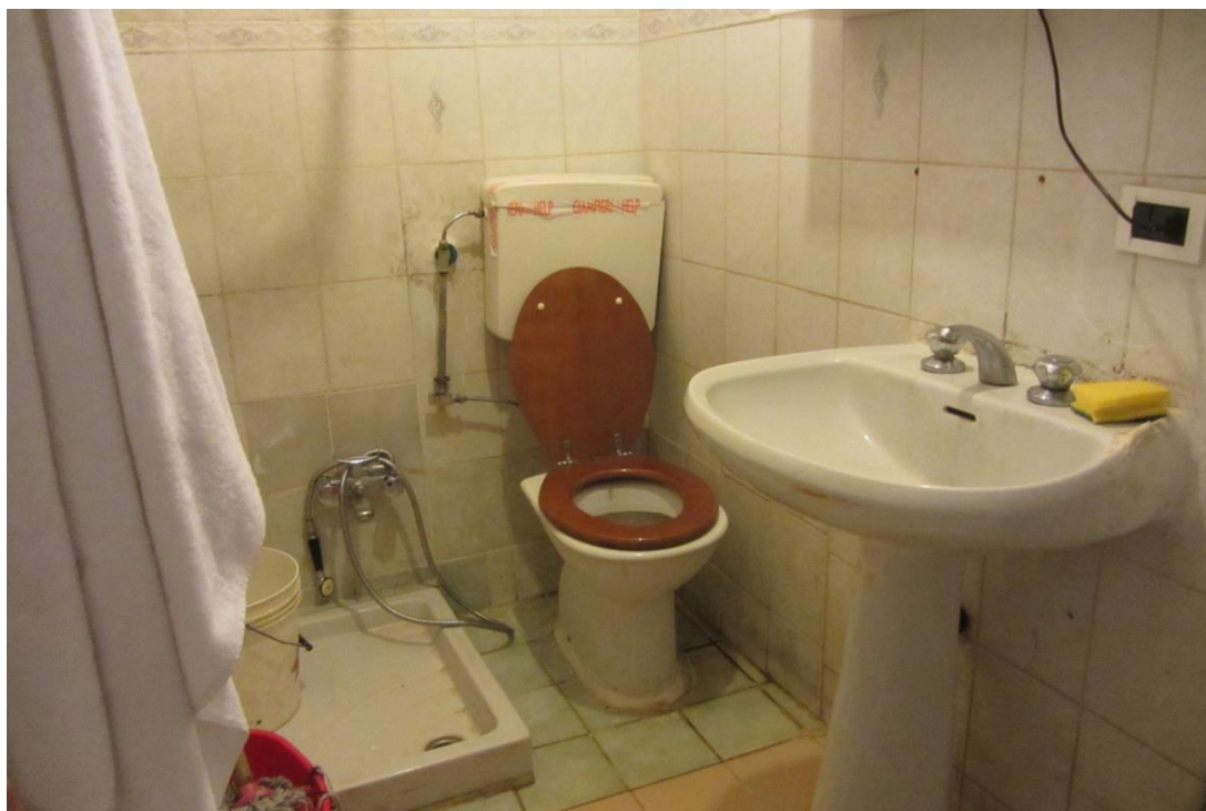
Vista del locale bagno.
