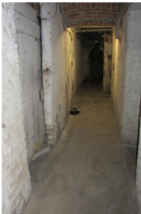
Vista del corridoio comune di accesso alle cantine.
