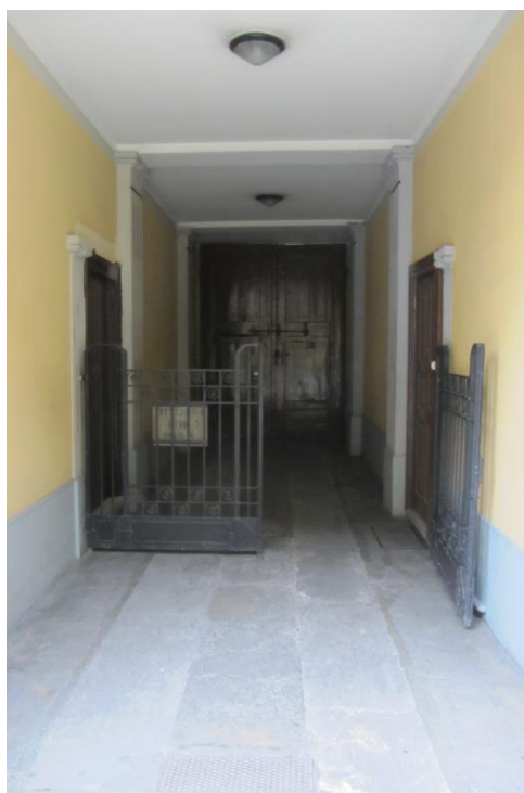
Vista dell'androne d'ingresso.
