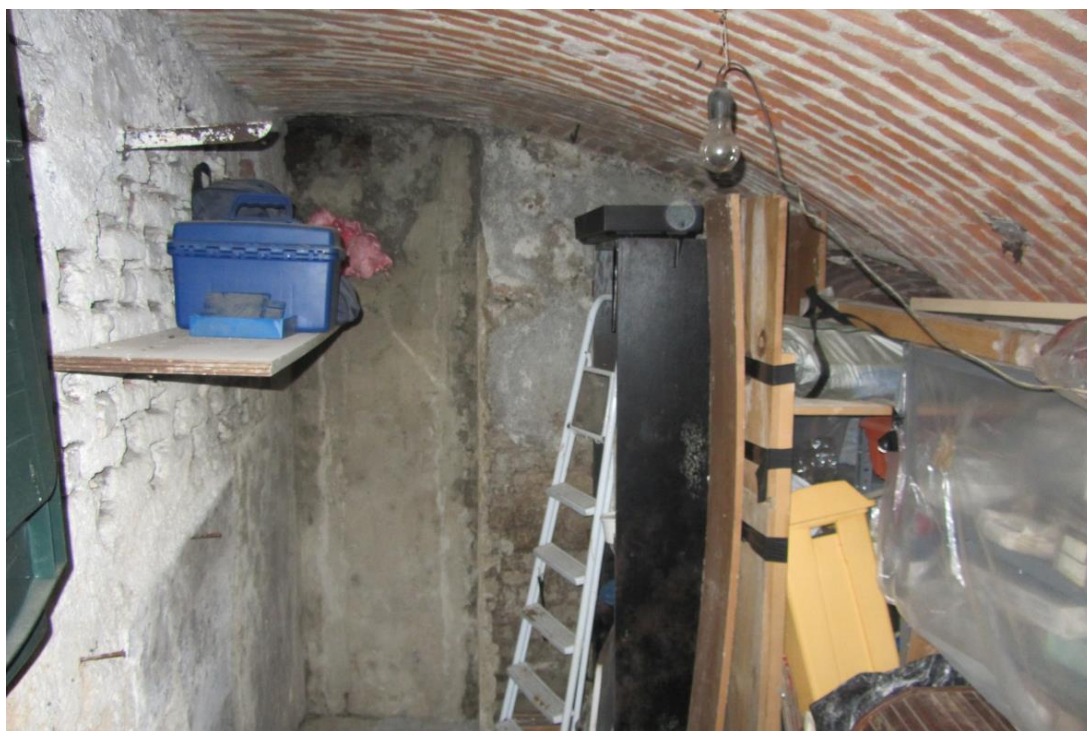
Vista del locale accessorio cantina.
