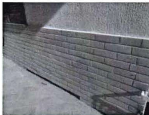
18. Dettaglio zoccolatura della facciata
