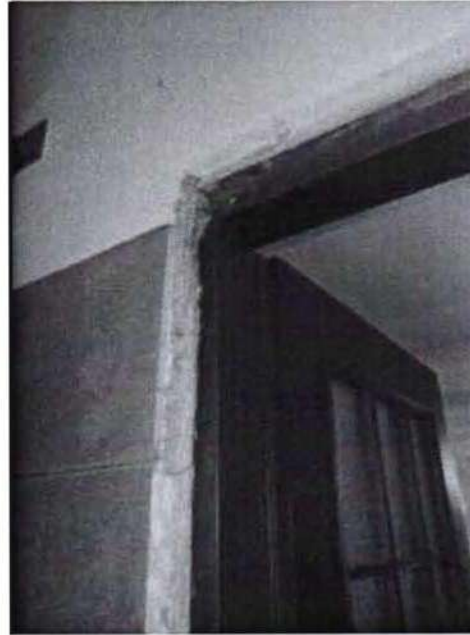
68. Dettaglio della finitura tra rivestimento del bagno e porta
