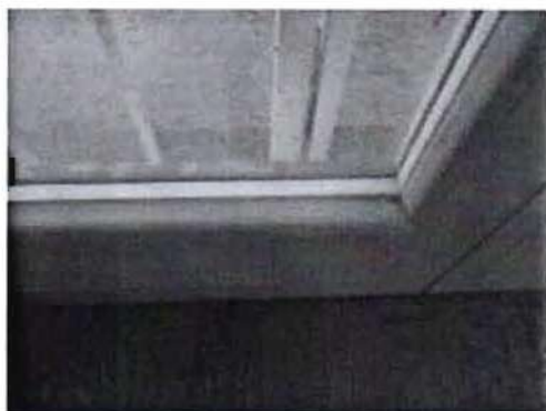
29. Dettaglio del serramento esterno
