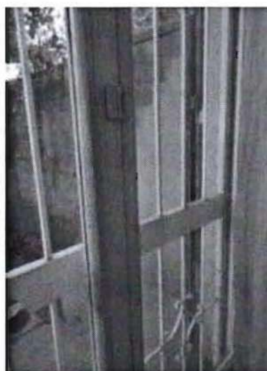
28. Dettaglio del serramento esterno
