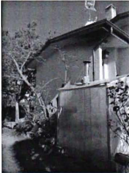
7. Struttura provvisoria nel giardino per ricovero caldaia
