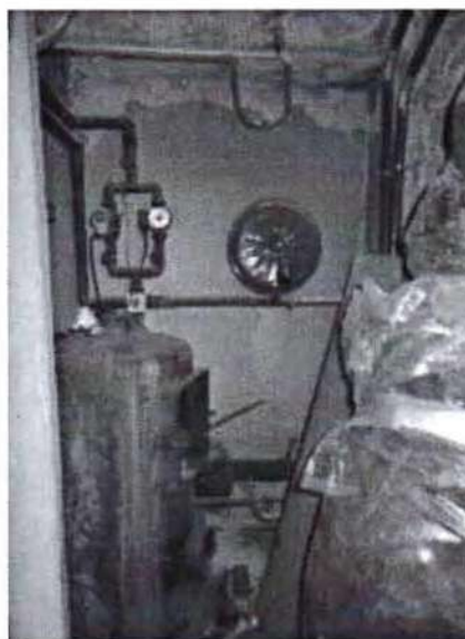
54. Locale caldaia (non in uso)
