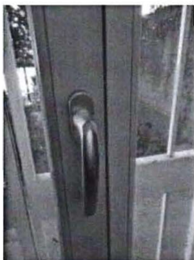
27. Dettaglio del serramento esterno
