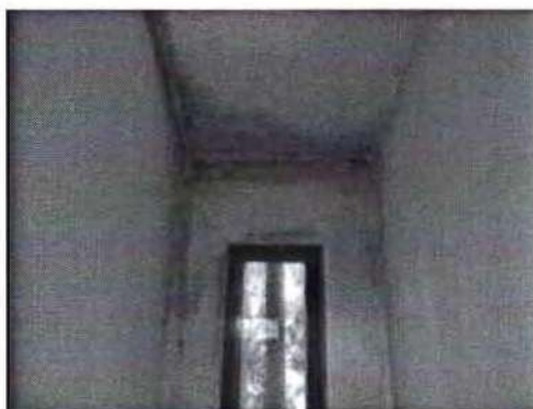
52. Particolare di muffe e ponti termici sulle murature del corpo scala
