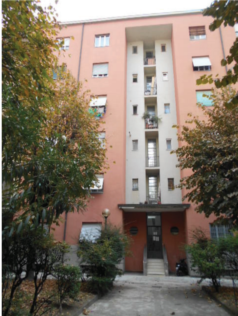
FOTO 6 – Dettaglio della facciata verso la scala D cortile interno
