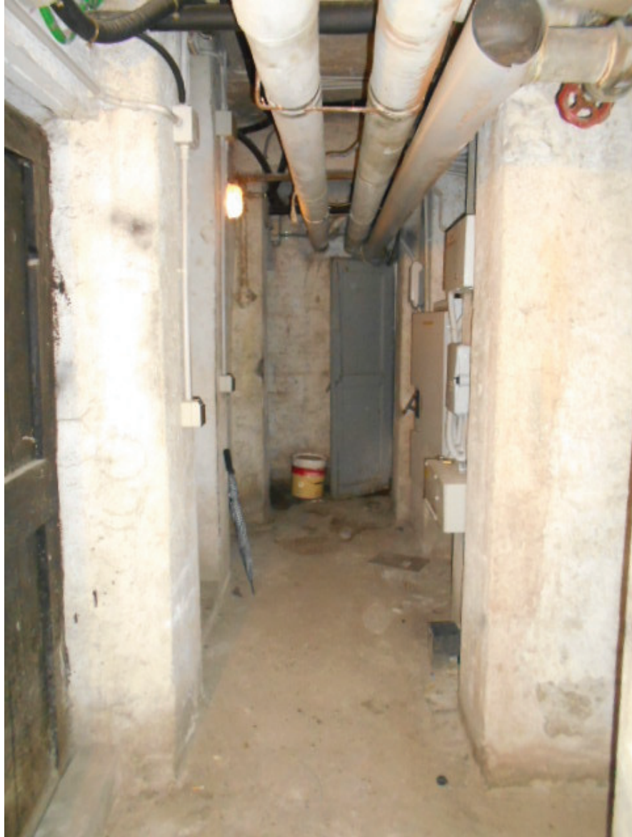
FOTO 15 – Corridoio comune cantine
