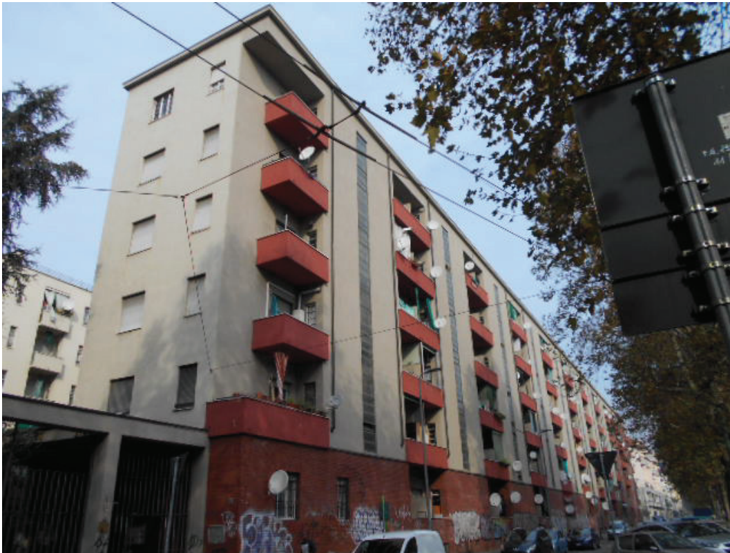
FOTO 4 – Vista del fabbricato oggetto di esecuzione al civico 5.
