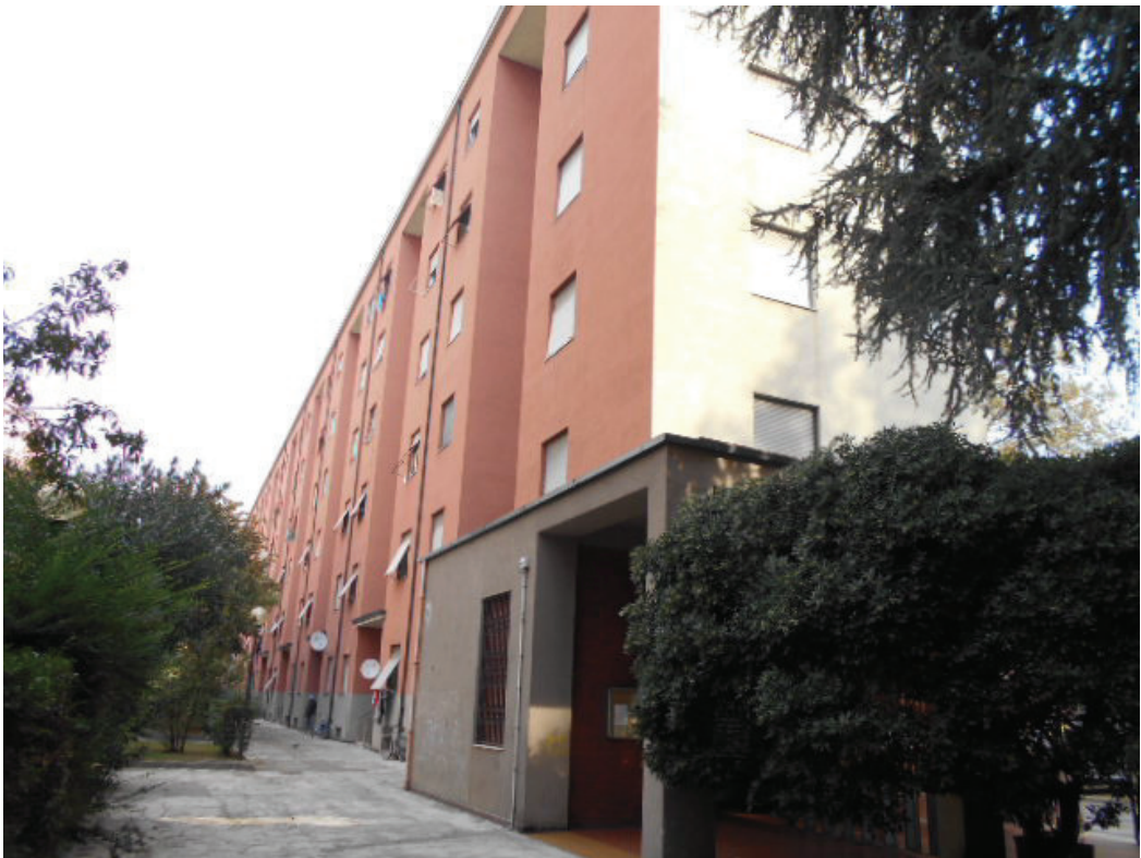
FOTO 5 – Dettaglio del fabbricato B1 in cui insiste l'unità immobiliare oggetto di esecuzione, vista dalla portineria d'ingresso
