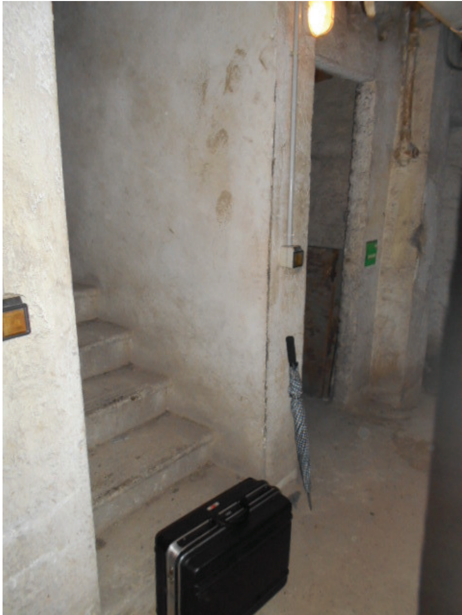
FOTO 16 – Posizione della cantina dal corridoio
