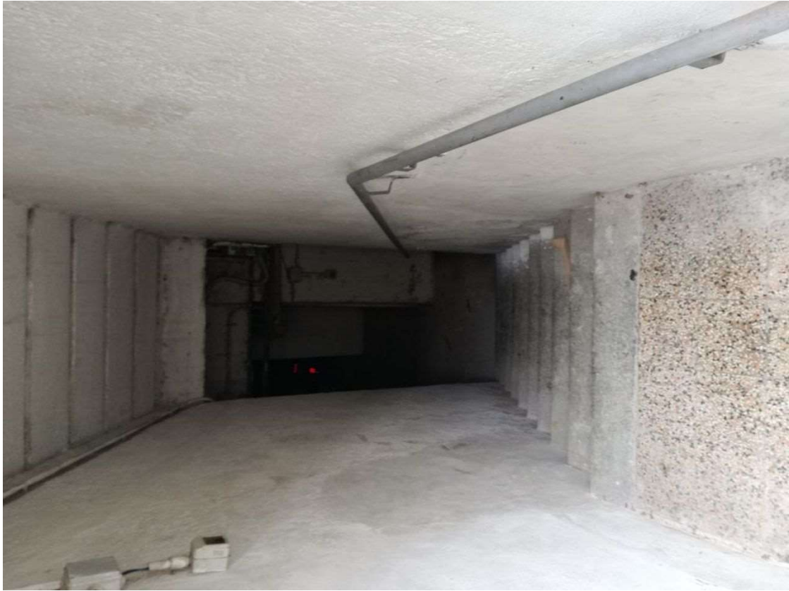
Scale accesso cantina
