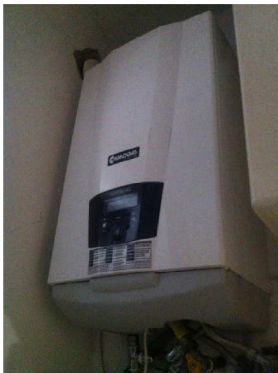
Caldaia a condensazione
