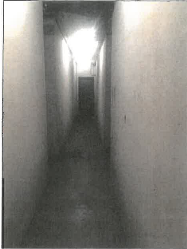
ACCESSO VANI CANTINA
