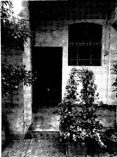
Accesso dal cortile interno del civico 6 di Piazza Sempione
