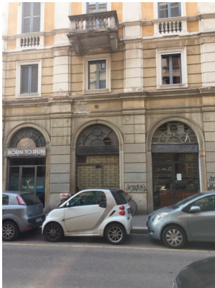
Rilievo fotografico - 27 marzo 2018 - Prospetti su Piazza Sempione e Via Cagnola
