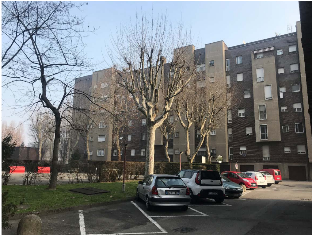
Foto n. 1: Prospetto principale su cortile interno.
