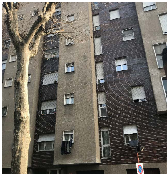
Foto n. 2: Ingresso al condominio
