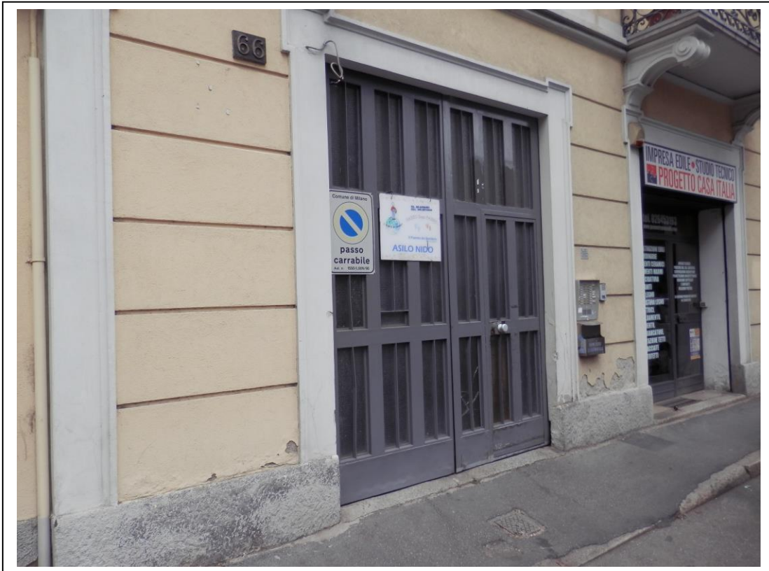
Fotografia n°3 – Vista della porta d'accesso pedonale e carraio da Via Brusuglio.
