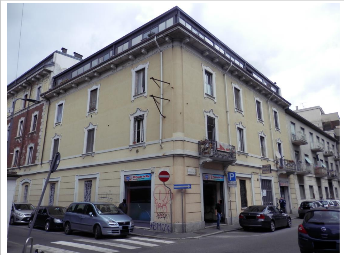
Fotografia n°1 – Vista delle facciate del fabbricato rivolte su fronte stradale.
