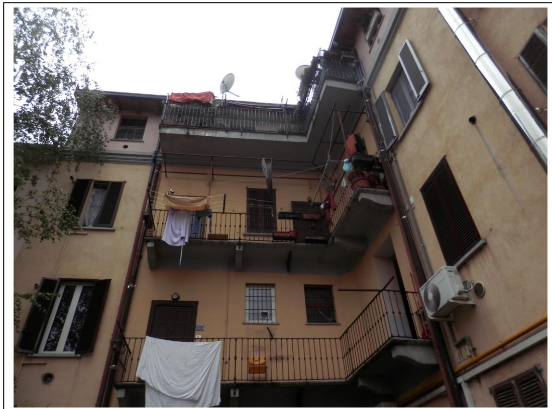
Fotografia n°2 – Vista della facciata del fabbricato rivolte su cortile interno.
