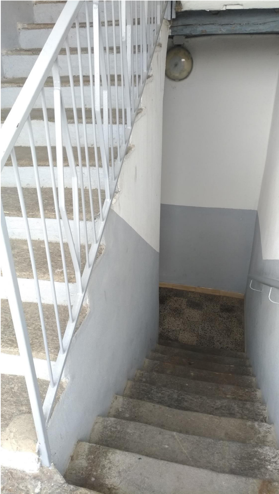
Immagine. 3. Scala comune di accesso al piano.
