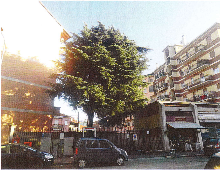
Vista esterna - ingresso pedonale fronte strada
