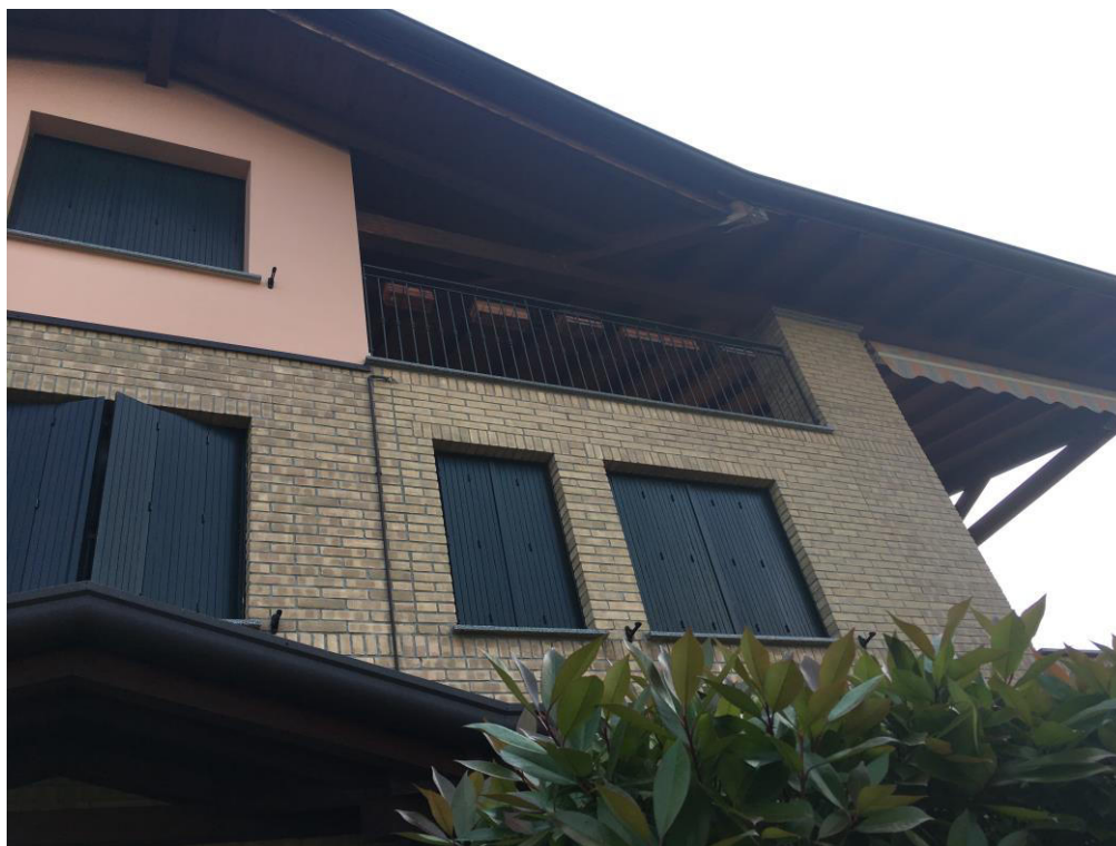
FOTO 1: LAINATE, VIA VAL SERIANA 39, fronte abitazione
