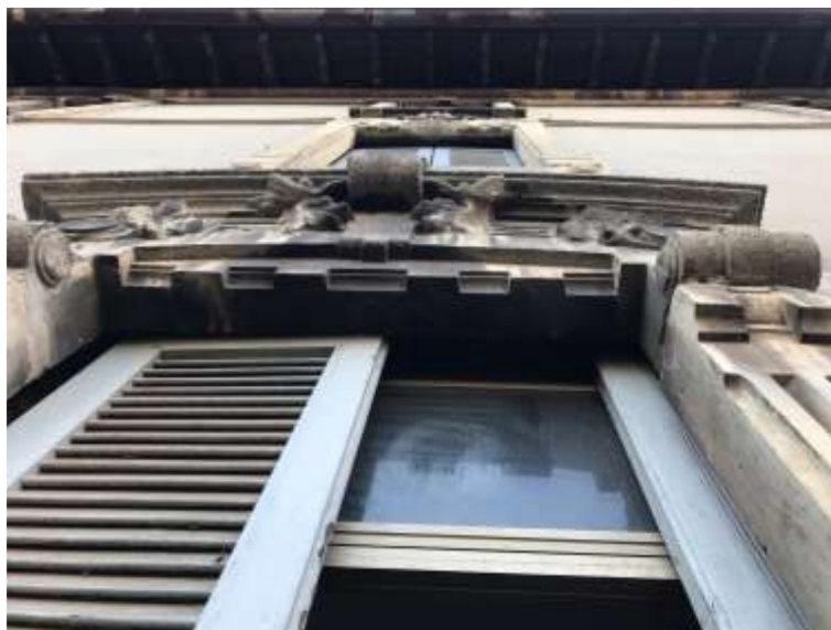
Immagine 18. Vista di dettaglio della Cornice decorata attorno alla porta - finestra della zona giorno.
