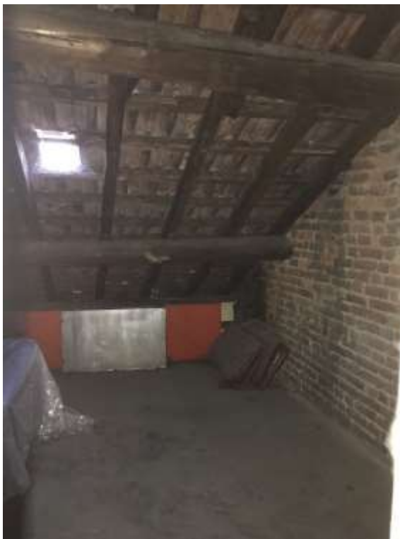
Immagine 23. L'interno del ripostiglio in solaio.
