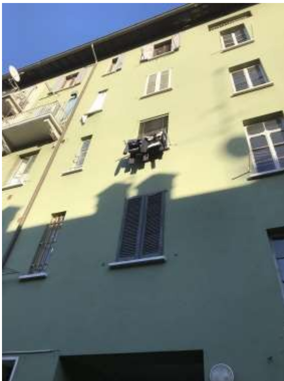
Immagine 4. Il fabbricato inquadrato dal cortile interno.
