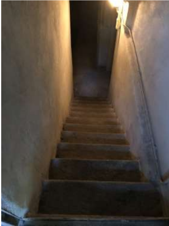
Immagine 25. La rampa di scale che consente l'accesso al piano seminterrato.
