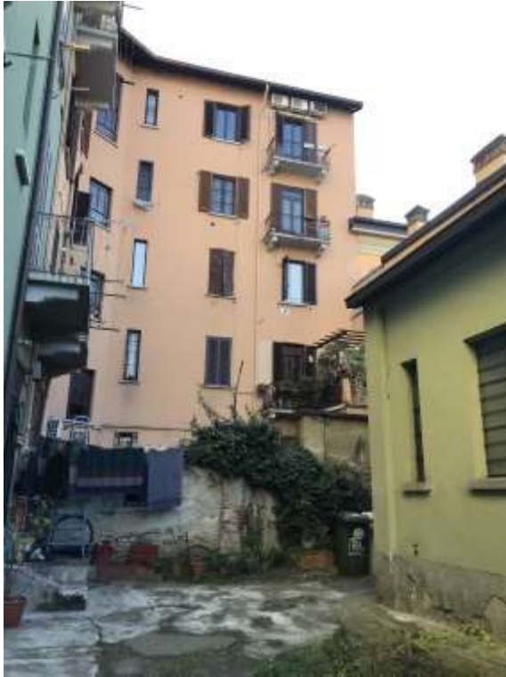
Immagine 7. Il cortile interno del fabbricato.
