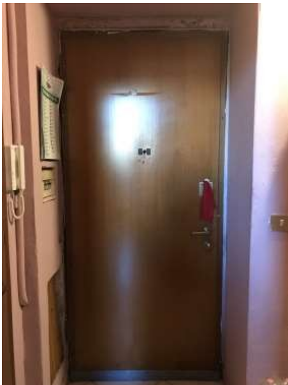
Immagine 12. Il portoncino di ingresso all'unità immobiliare, inquadrato dall'interno.
