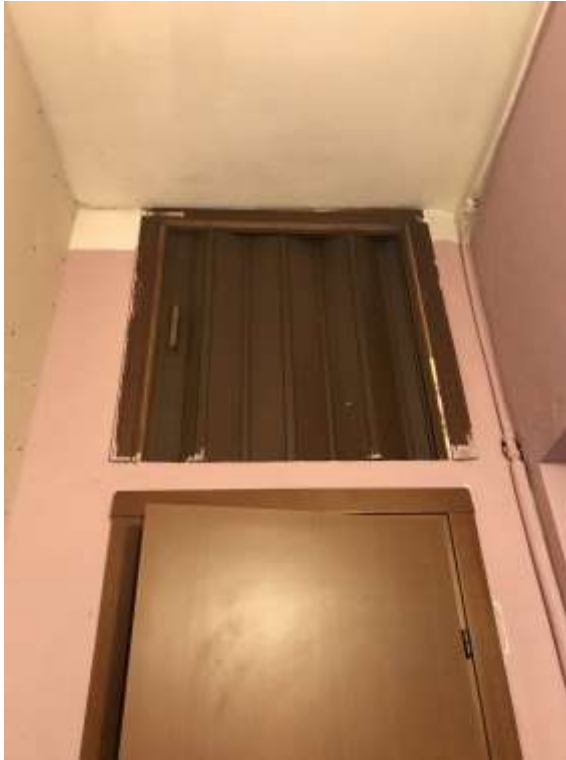
Immagine 23. L'accesso al ripostiglio in quota, posizionato superiormente al bagno.
