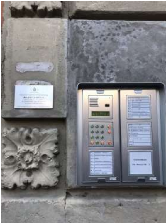
Immagine 2. Vista dei citofoni, collocati accanto al portone di ingresso al fabbricato.
