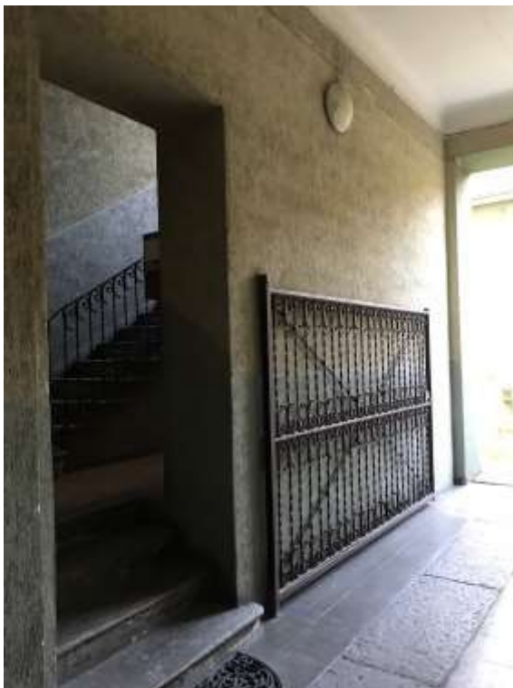
Immagine 7. L'accesso al vano scale condominiali.
