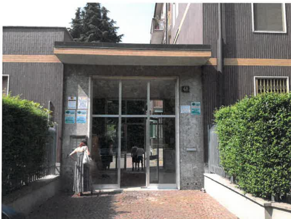
Foto 1 - Vista su ingresso da via Ravenna 48
