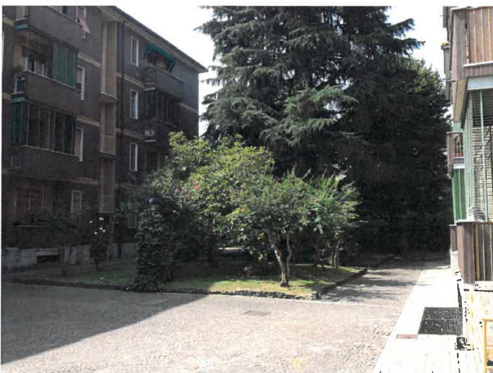
Foto 2 - Vista su cortile interno
