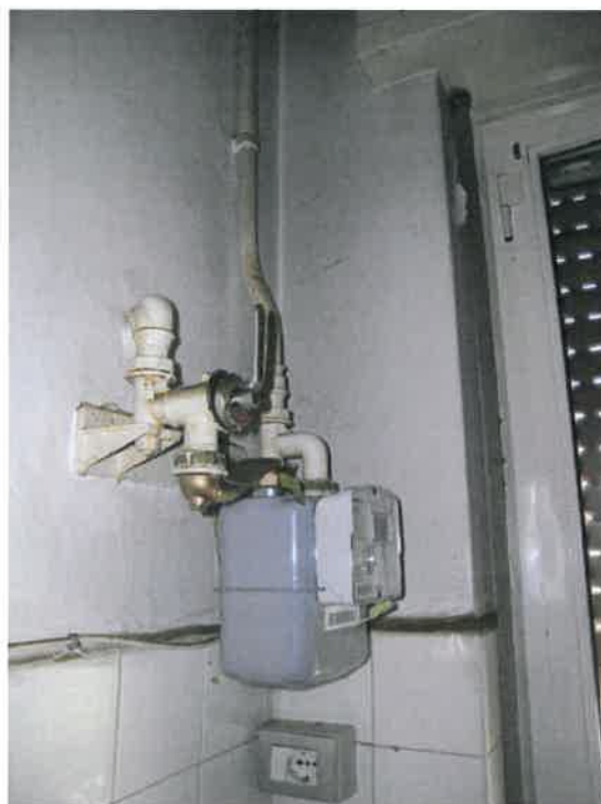
Foto 23 - Contatore gas
