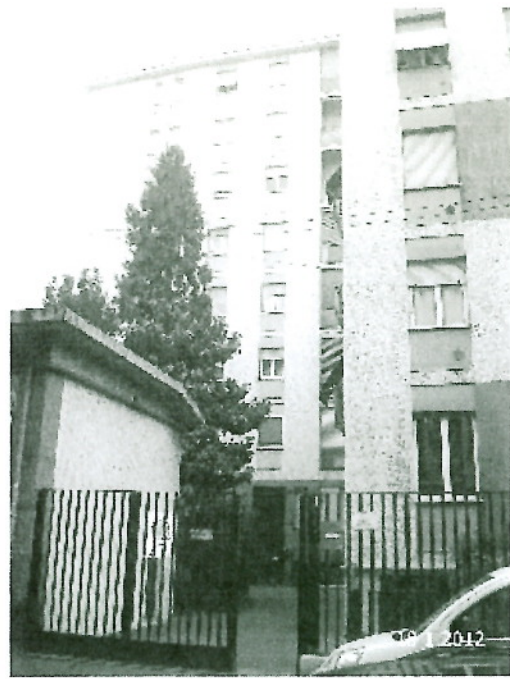
VIA TOSCANELLI, 1B - FRONTE
