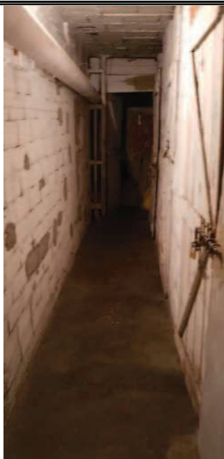
Appartamento pignorato - corridoio piano interrato cantinato
