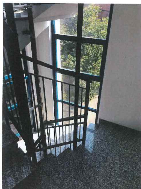
Foto 4 - vano scala comune
